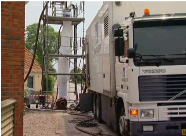
Weinig gebruik van openbare ruimte om de leiding aan te brengen.
