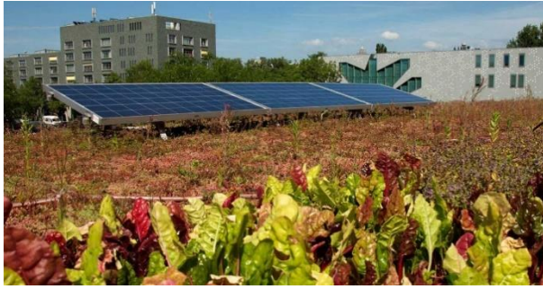
Groen dak met zonnepanelen
