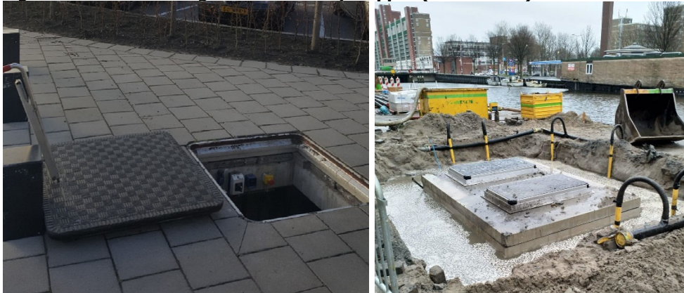
Figuur 6.3 Putafwerking en constructie pompput (foto: VHGM)
