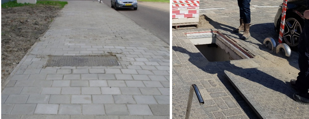
Figuur 6.2 Bronafwerking gelijk aan maaiveld; rechts ventilatieleidingen boven maaiveld
