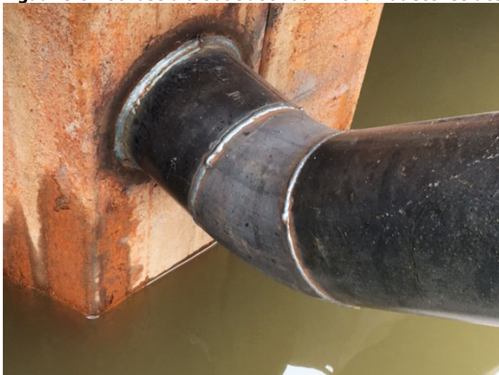
Figuur 5.6 Voorbeeld uitlaat door damwand kadeconstructie (foto: VHGM)
