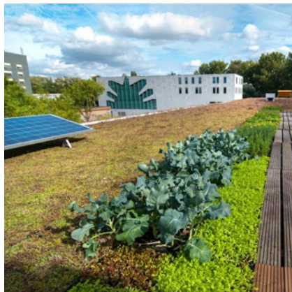
polderdak: waterberging op het dak
