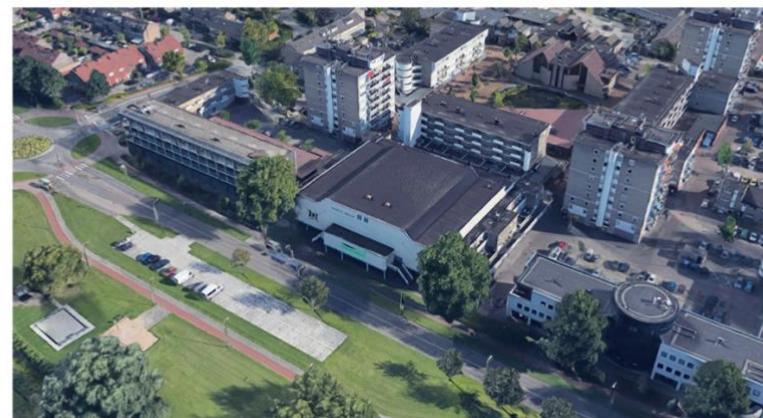
Luchtfoto Bestaande Situatie
