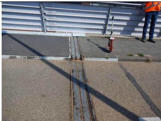
Voegovergangsconstructie fietspad oostzijde
