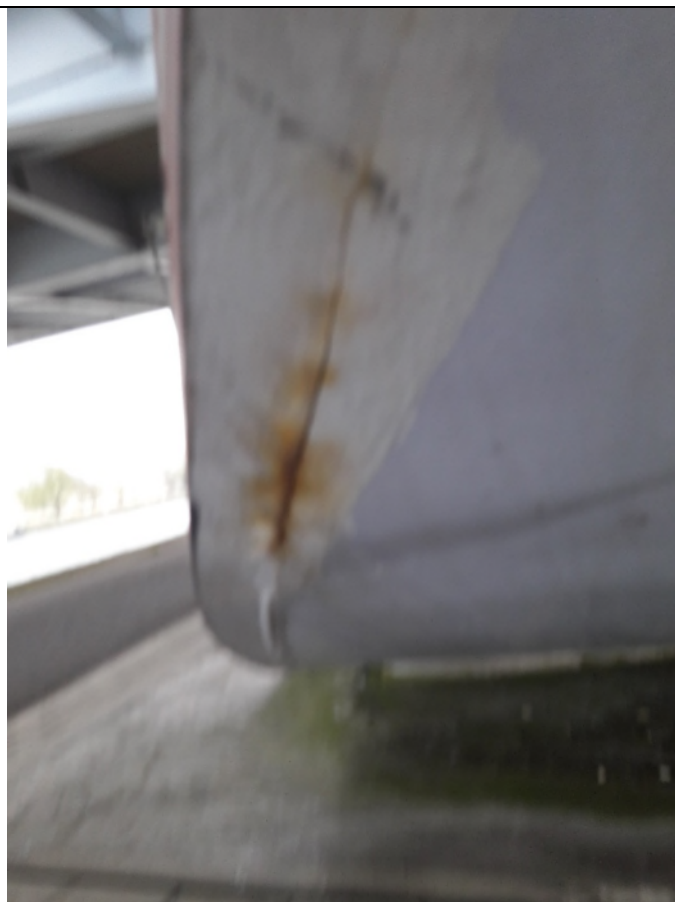
Pyloon, scheur in las (noordoosthoek) Tekening 6, 9 AM (03)
