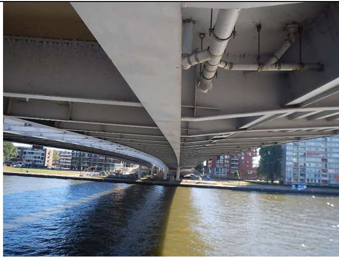
HWA, afvoerleiding Algemeen beeld leidingloop met aansluiting kolken
