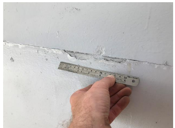
Afbeelding 14: Onthechting verflaag nabij scheur
