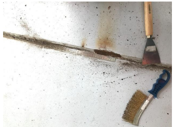
Afbeelding 10: Aansluiting staalplaten
