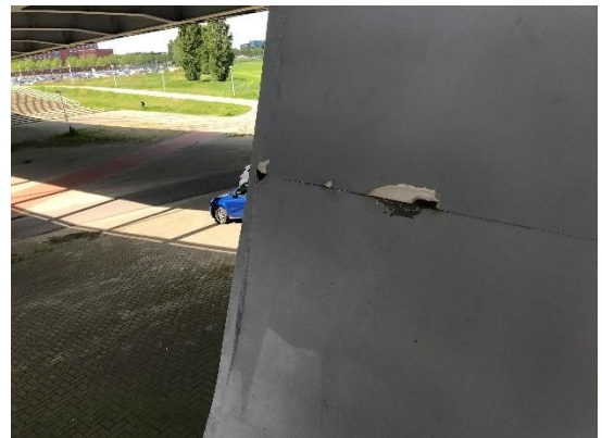
Afbeelding 26: Aansluiting t.p.v. twee stalen platen
