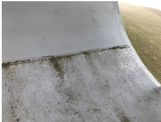
Afbeelding 7: Aansluiting staalplaten
