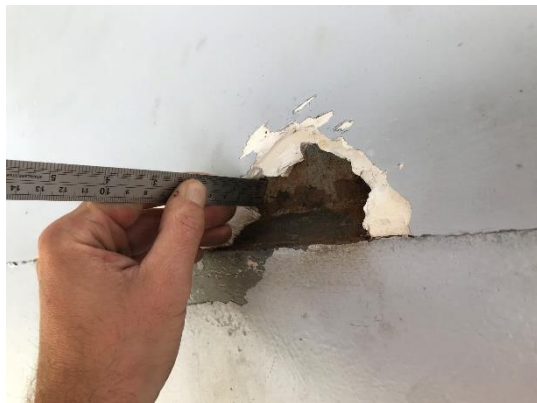
Afbeelding 25: Dikte afwerklaag
