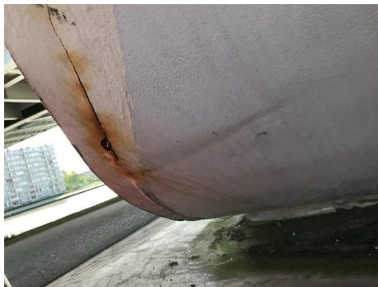
Afbeelding 3: Scheur en bolling
