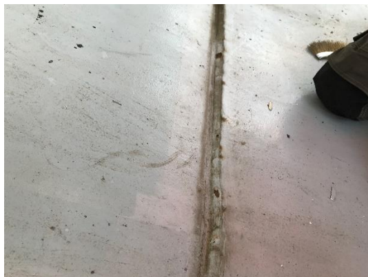
Afbeelding 21: Goot t.p.v. aansluiting twee stalen platen
