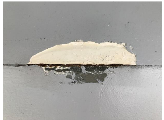
Afbeelding 24: Corrosie t.p.v. lasnaad
