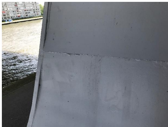
Afbeelding 11: Aansluiting van staalplaten
