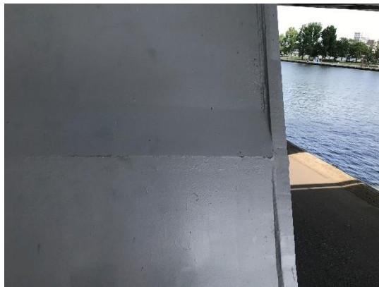
Afbeelding 23: Aansluiting t.p.v. twee stalen platen
