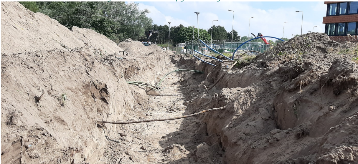
Figuur 5: Aanwezige kabels en leidingen.
