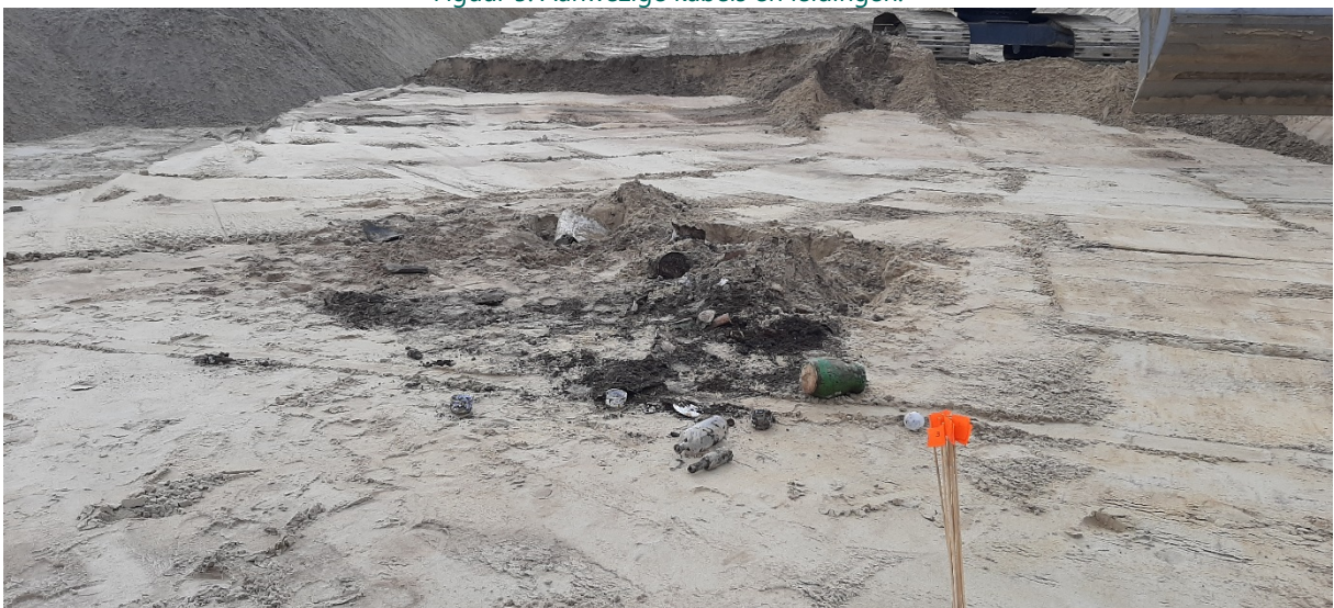
Figuur 6: Aangetroffen vuilput.
