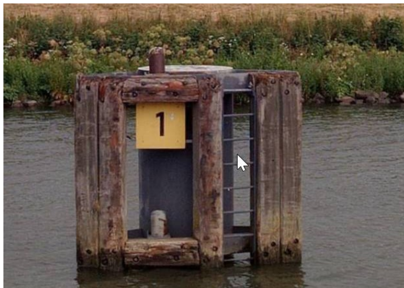
Aanlegvoorziening Noordelijke voorhaven
