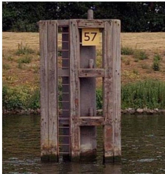
Aanlegvoorziening Zuidelijke voorhaven
