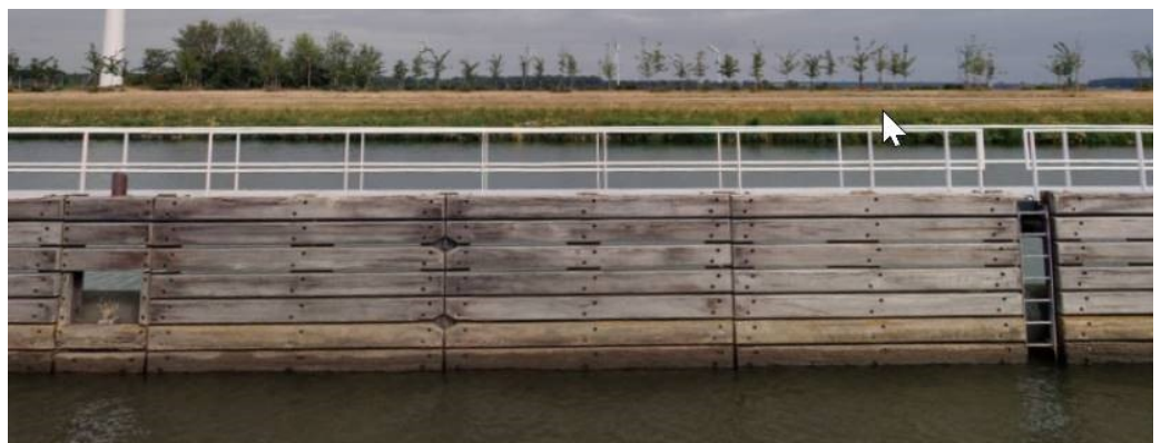
Remmingwerken Noordelijke voorhaven
