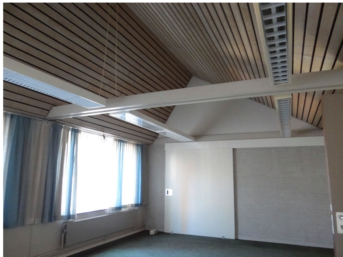
museale ruimte 2e verdieping
