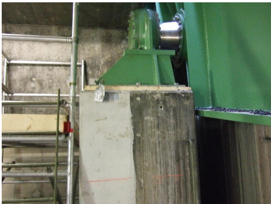
Bij de Schinkelbrug is de beton poer aan de buitenzijde uitgebreid met een derde ankerrij en een aangestorte verbreding van de bestaande poer. Voor zover bekend zijn de bestaande anders niet vervangen. Onderstoel, lagerhuis en as zijn vernieuwd. Onderstoel is uitgevoerd met kluft.
