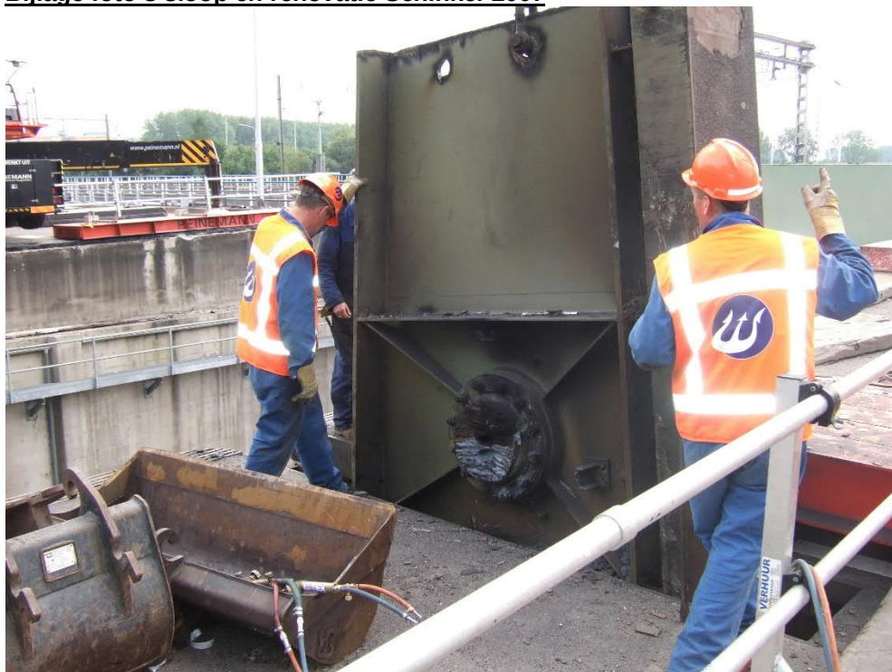
Om de staartstukken van het oude stalen val snel te kunnen demonteren en afvoeren is de hoofddraaipuntsas doorgebrand
