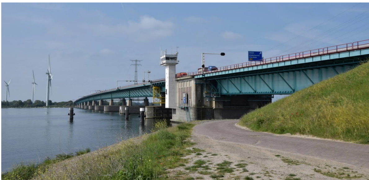
Figuur 1-1: Haringvlietbrug- Noordzijde
