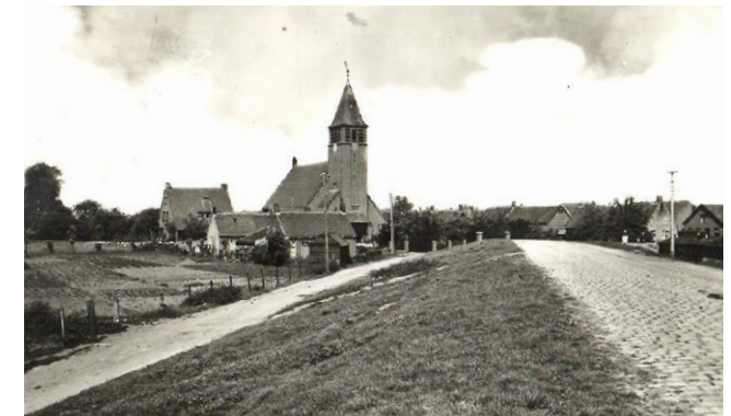
kerk en pastorie onderaan het dijktracé
