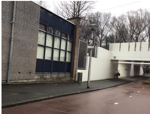
Meent zijde centrum viaduct.
