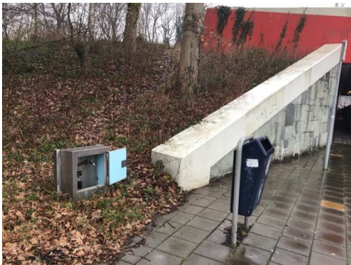
Oranjebaan zijde centrum viaduct.
