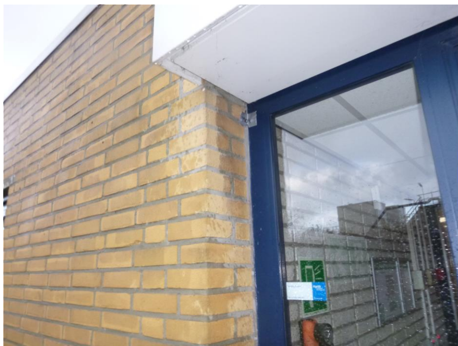
Foto F11, Afdichtingskit type 2 - Hoofdgebouw
