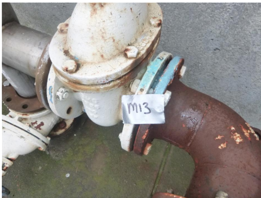
Foto F43, Flenspakking - T.h.v. Fijnrooster 1
