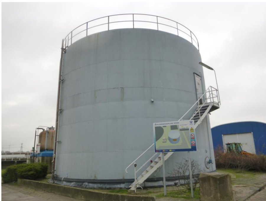
Foto F29, Flenspakking type 3 - Gashouder
