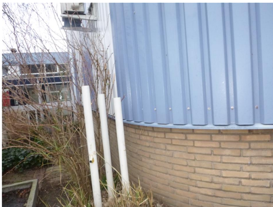
Foto F15, Coating waterkering - Warmte krachtgebouw
