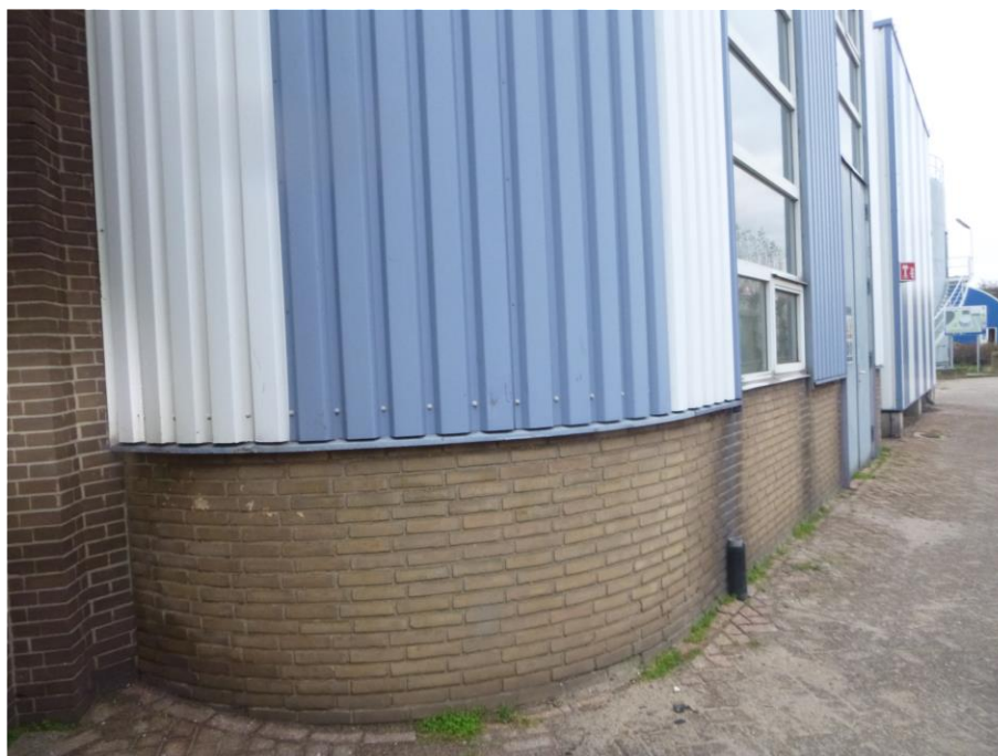
Foto F17, Coating waterkering - Warmte krachtgebouw
