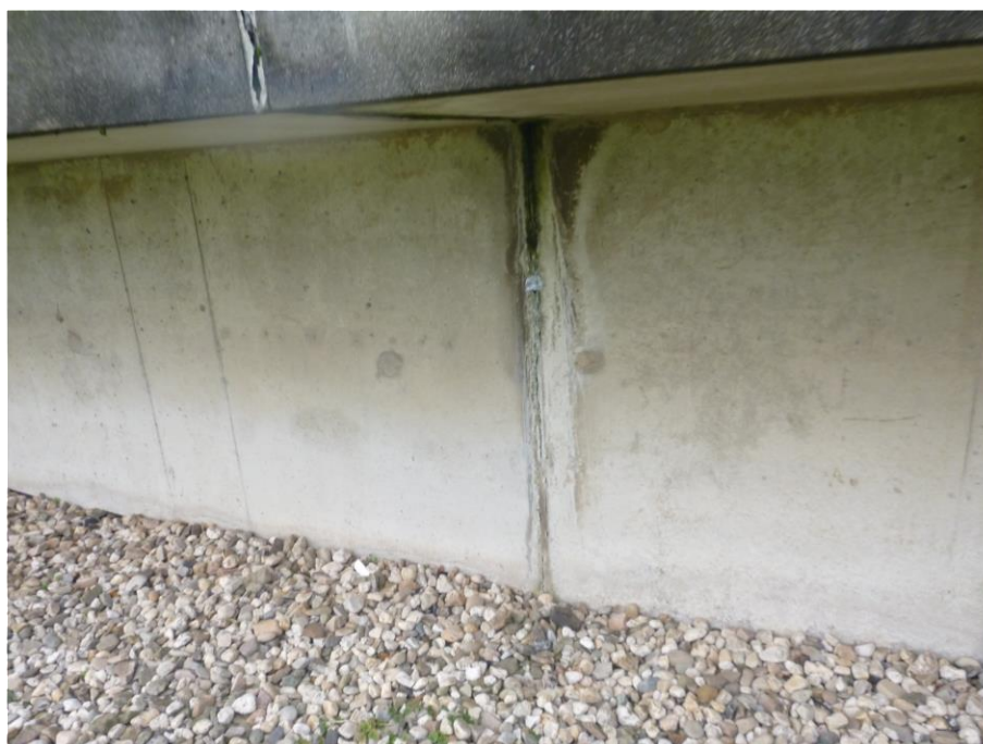
Foto F34, Afdichtingskit type 5 - Denitrificatietank 2
