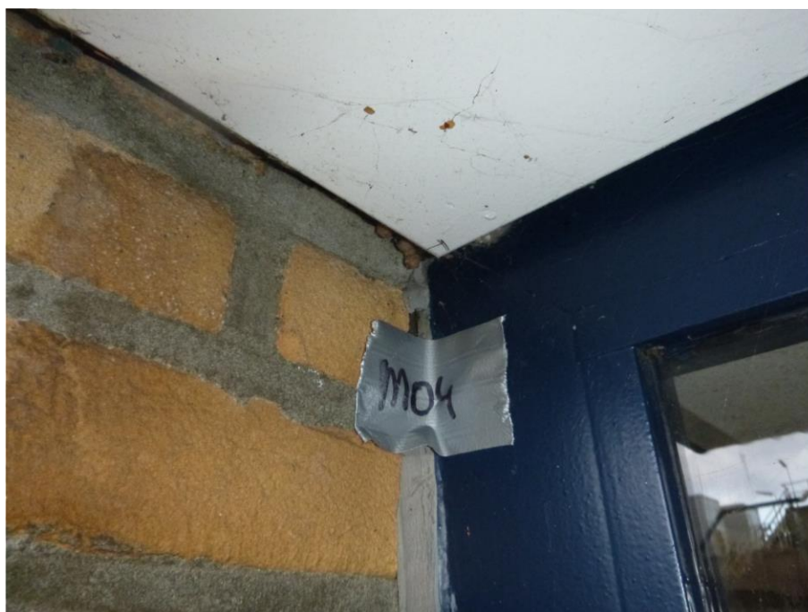
Foto F10, Afdichtingskit type 2 - Hoofdgebouw
