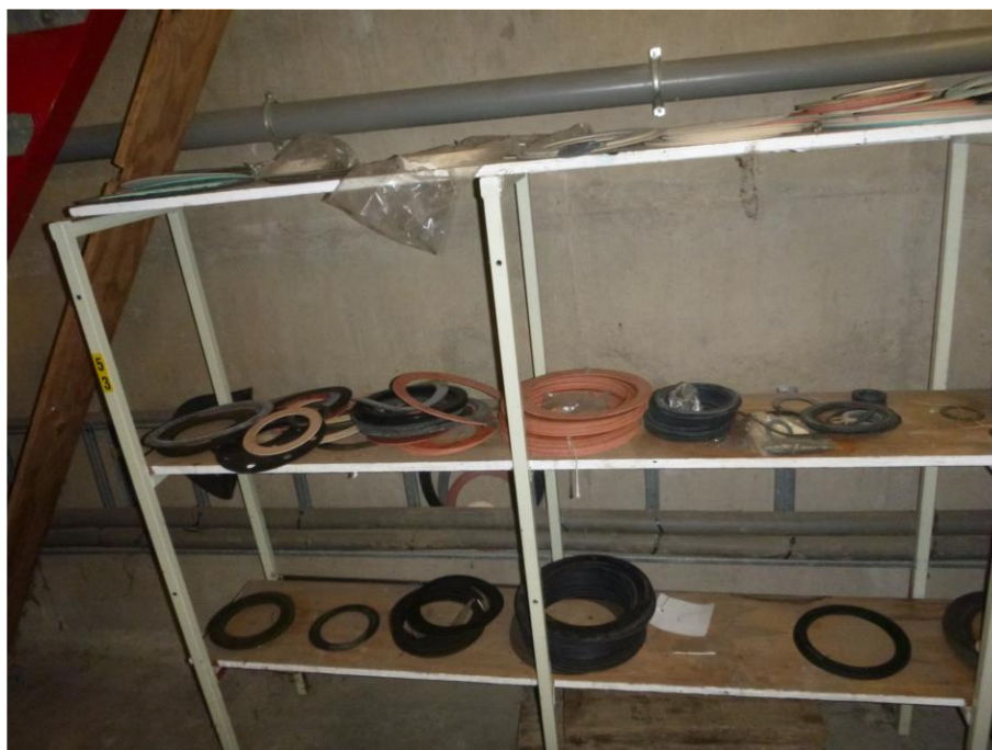
Foto F07, Flenspakkingen type 2 - Warmte krachtgebouw
