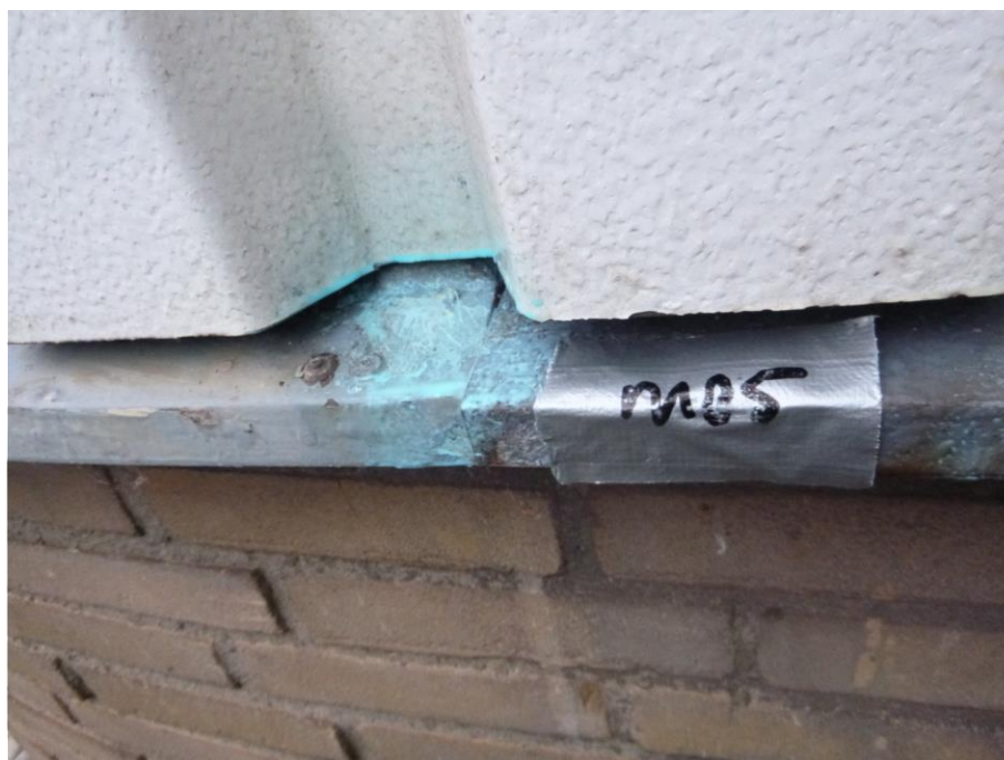
Foto F13, Coating waterkering - Warmte krachtgebouw
