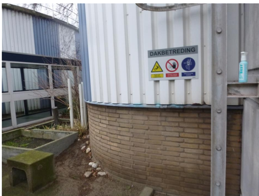
Foto F14, Coating waterkering - Warmte krachtgebouw
