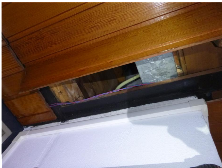
Foto F08, Afdichtingskit type 1 - Hoofdgebouw
