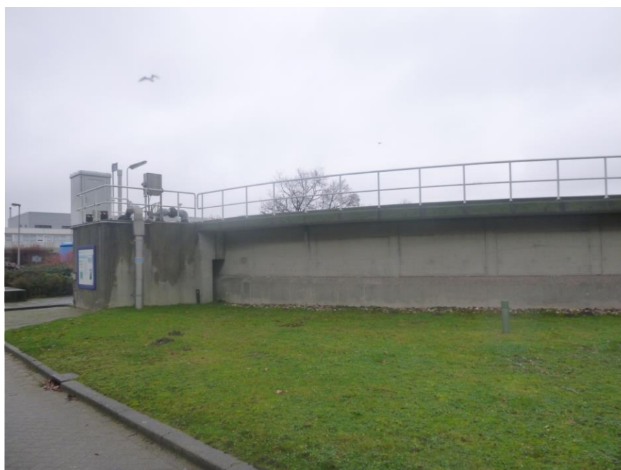
Foto F36, Afdichtingskit type 6 - Voorbezinktank
