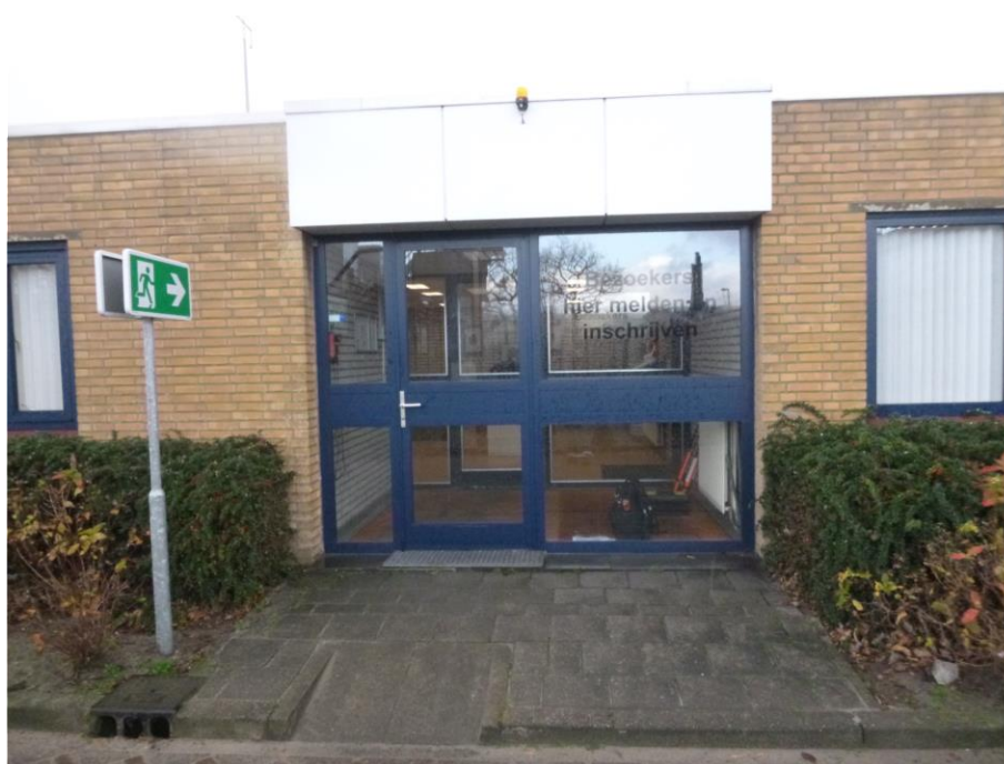
Foto F12, Afdichtingskit type 2 - Hoofdgebouw
