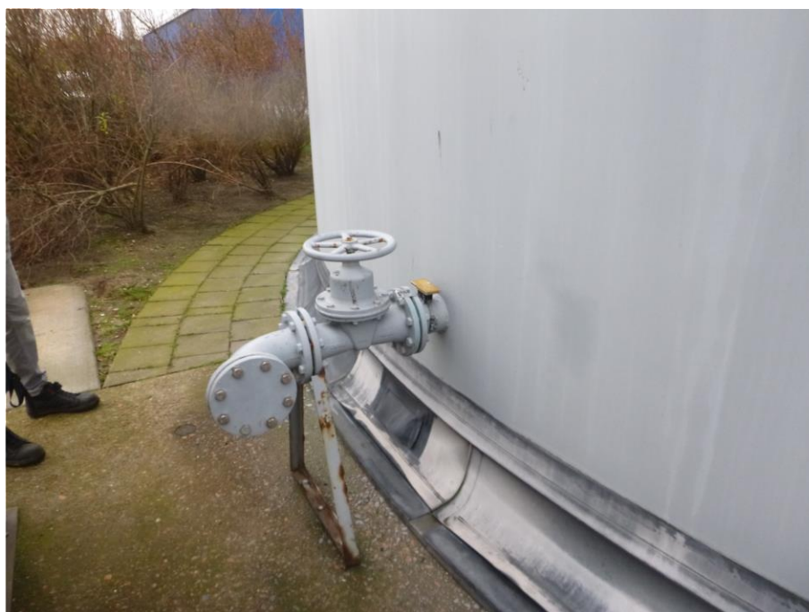
Foto F28, Flenspakking type 3 - Gashouder
