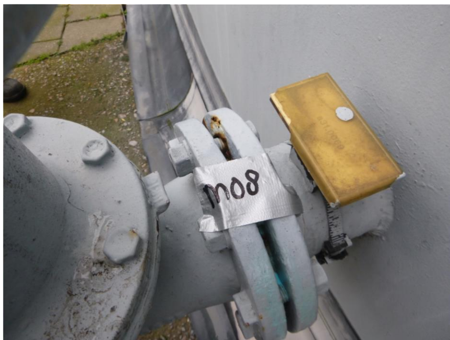
Foto F27, Flenspakking type 3 - Gashouder
