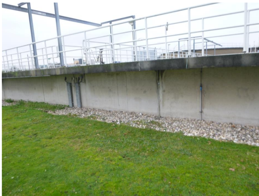
Foto F35, Afdichtingskit type 5 - Denitrificatietank 2
