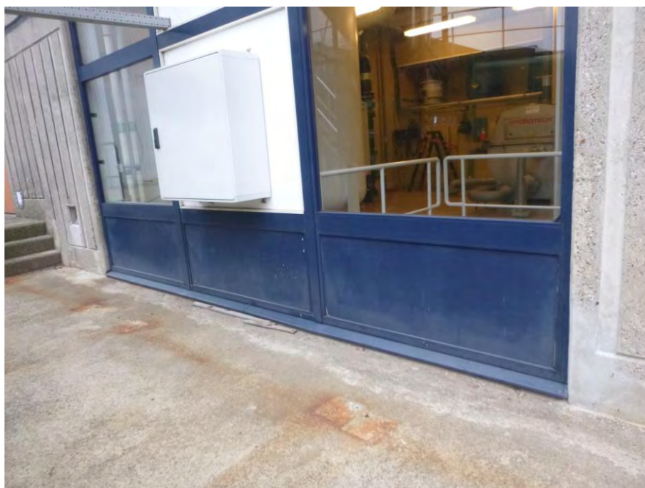
Foto F26, Gevelbeplating type 2 - Dienstgebouw 2
