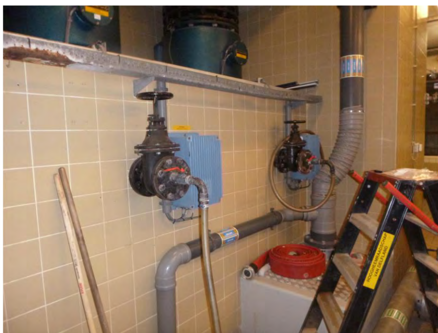
Foto F82, Bonnetpakking - Dienstgebouw 2
