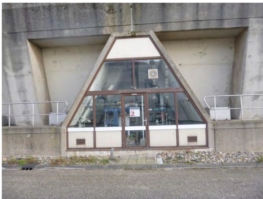
Foto F28, Gevelbeplating type 2 - voorbezinktanks / beluchtingstanks
