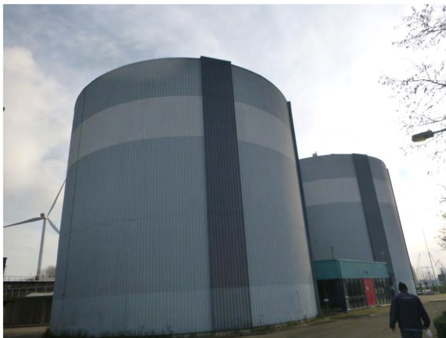
Foto F61, Beplating - Sliggistingstank 1 & 2
