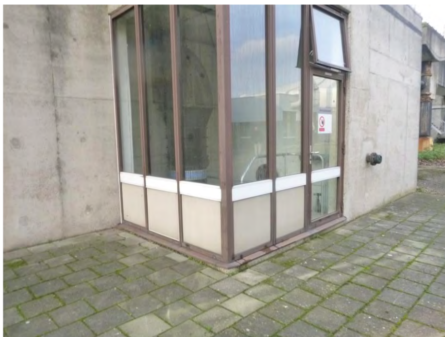
Foto F34, Gevelbeplating type 2 - voorbezinktanks / beluchtingstanks
