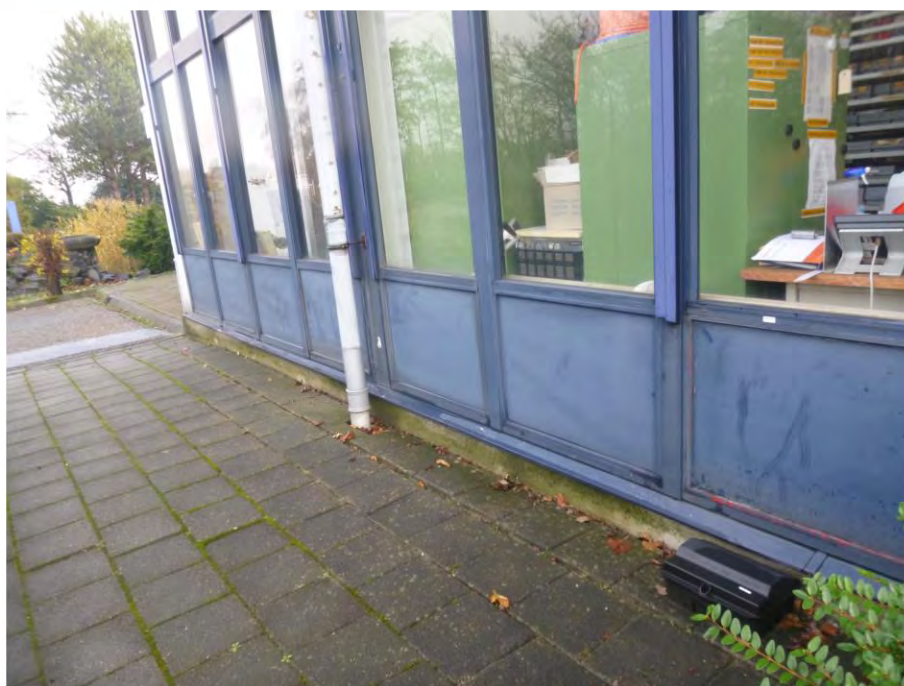
Foto F15, Gevelbeplating type 2 - Dienstgebouw 01
