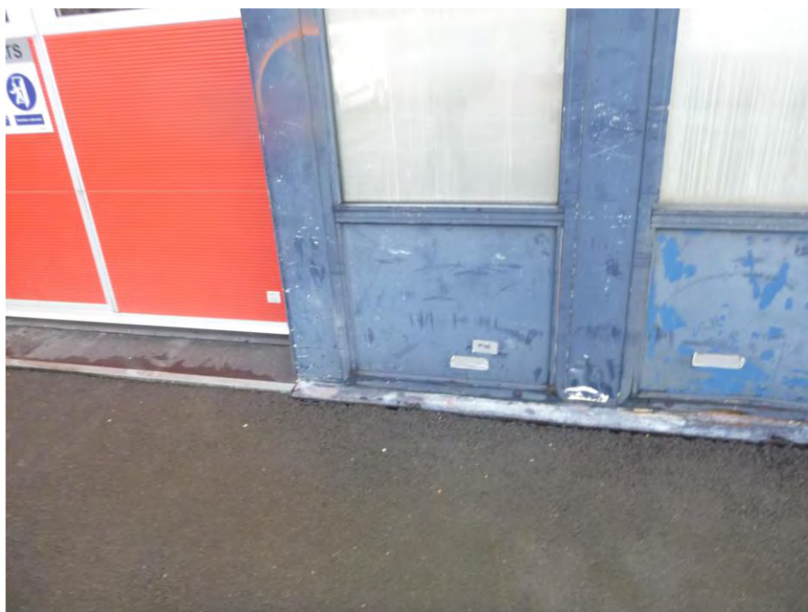
Foto F14, Gevelbeplating type 2 - Dienstgebouw 01
