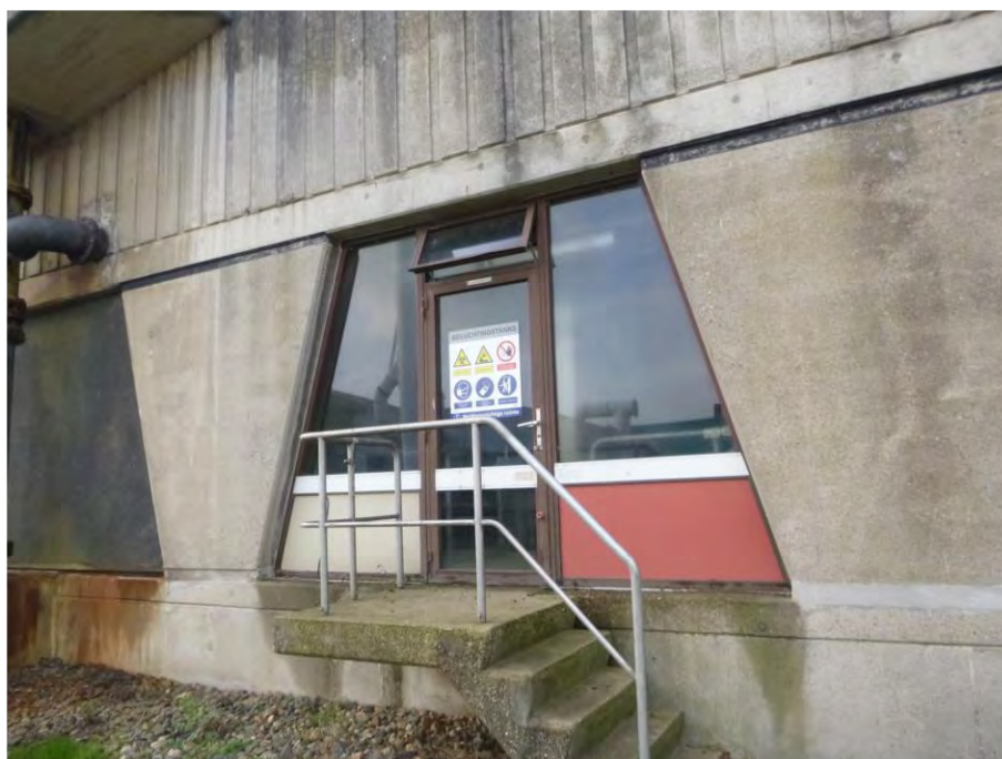
Foto F32, Gevelbeplating type 2 - voorbezinktanks / beluchtingstanks
