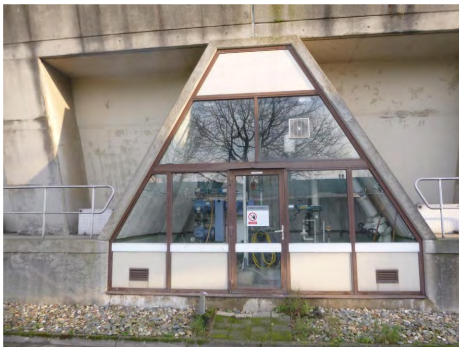
Foto F29, Gevelbeplating type 2 - voorbezinktanks / beluchtingstanks
