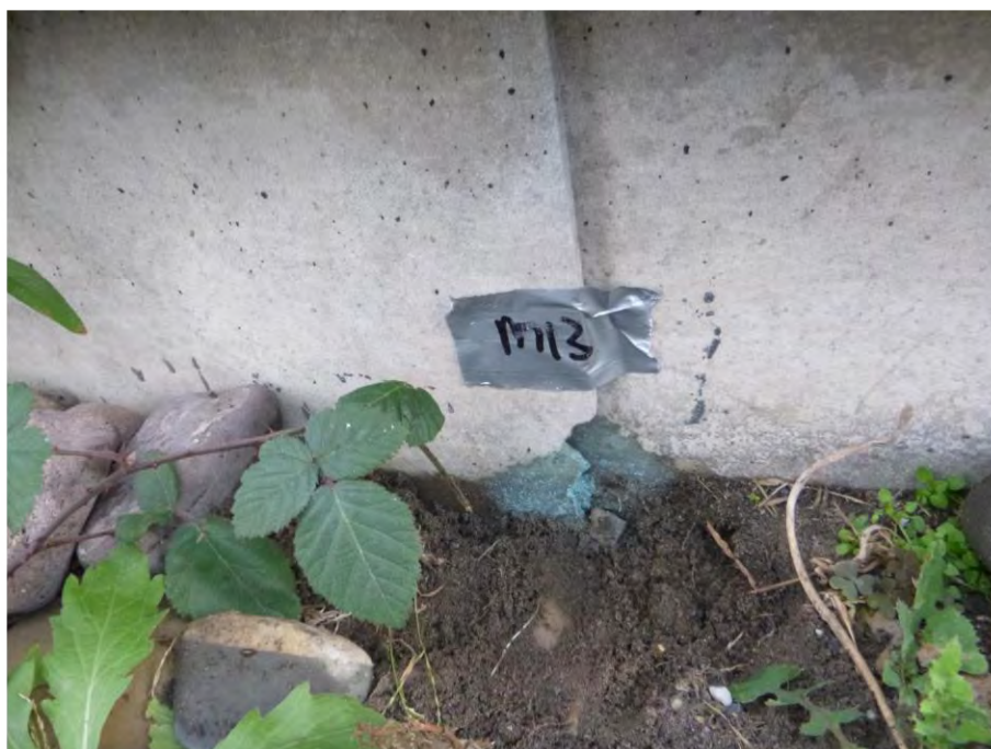
Foto F62, Beplating - Sliggistingstank 1 & 2
