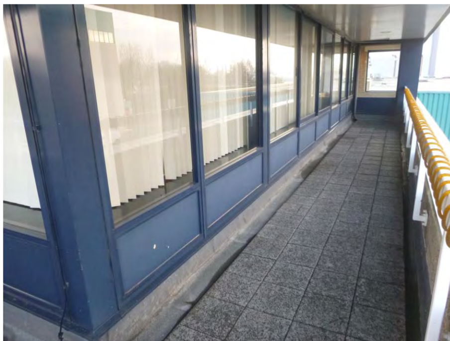
Foto F19, Gevelbeplating type 2 - Dienstgebouw 01
