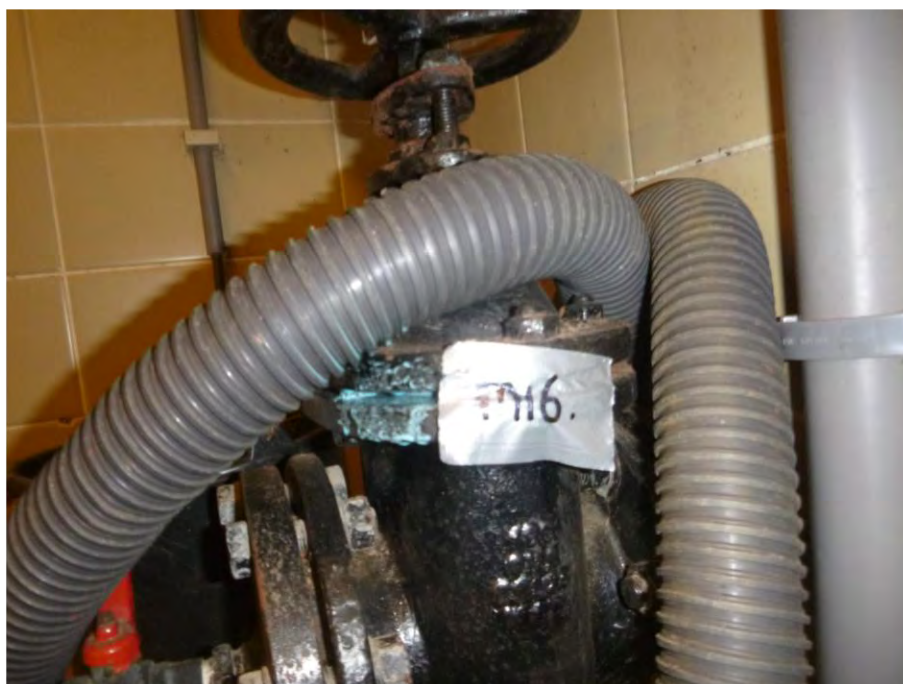
Foto F80, Bonnetpakking - Dienstgebouw 2
