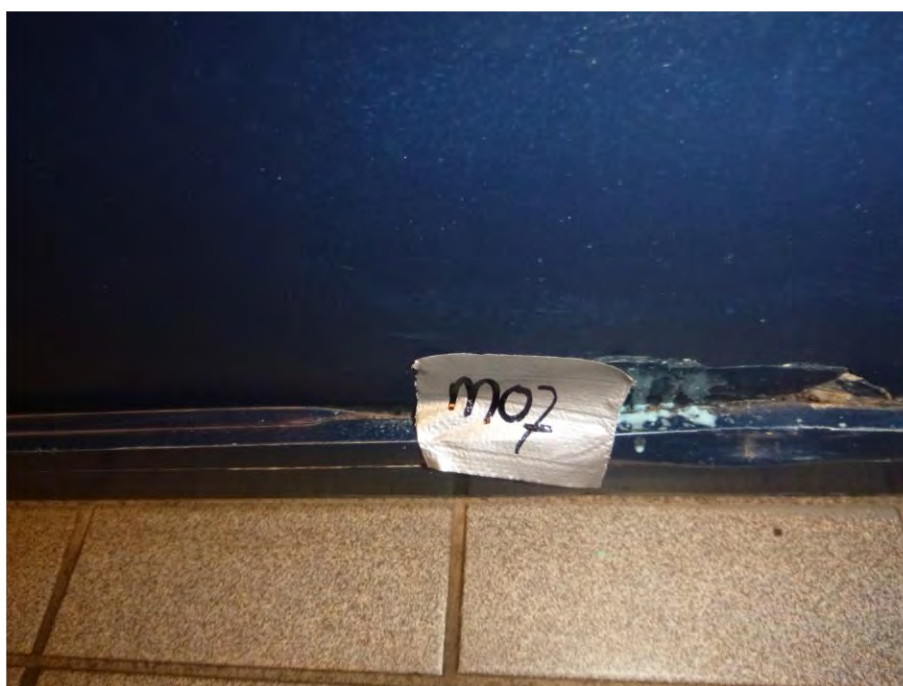
Foto F36, Kozijnbeplating (binnen) - Dienstgebouw 01
