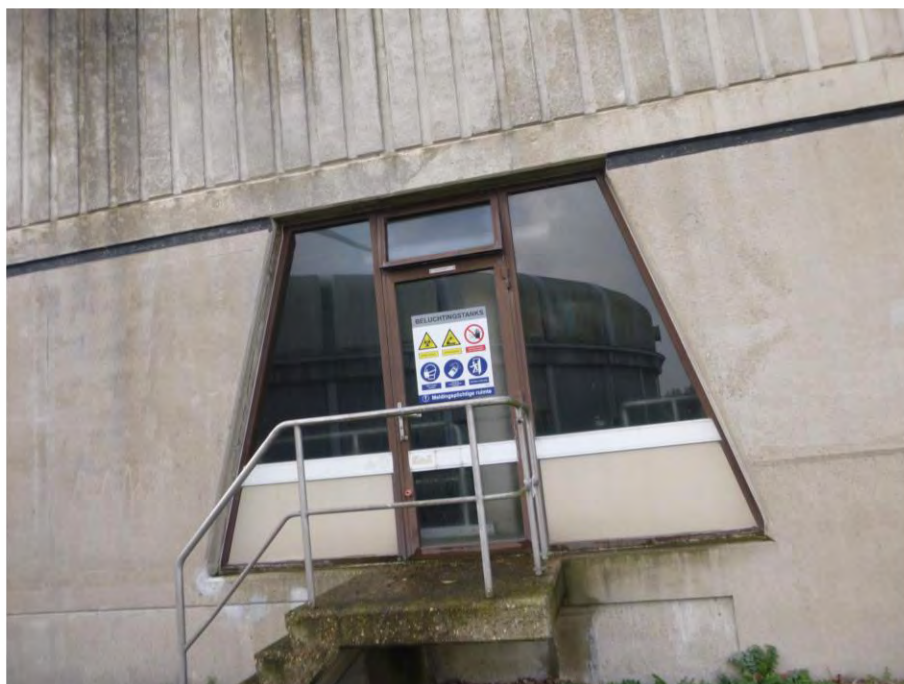
Foto F33, Gevelbeplating type 2 - voorbezinktanks / beluchtingstanks
