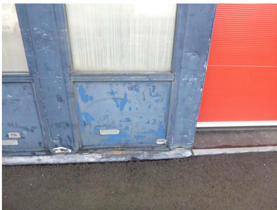
Foto F12, Gevelbeplating type 1 - Dienstgebouw 01
