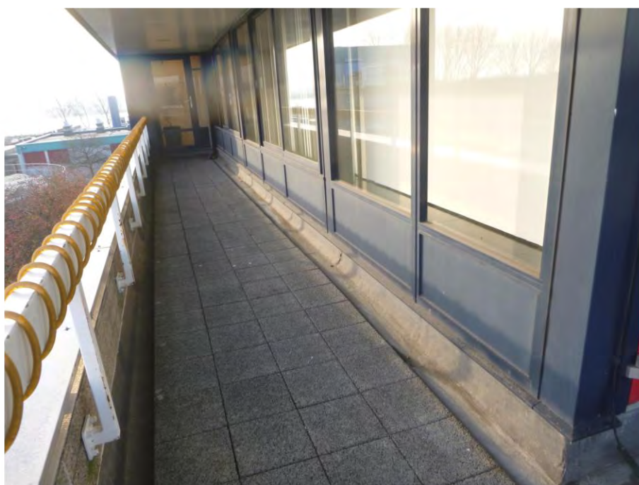
Foto F18, Gevelbeplating type 2 - Dienstgebouw 01
