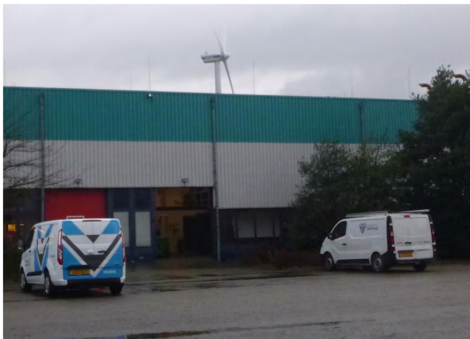
Foto F21, Gevelbeplating type 2 - Dienstgebouw 01
