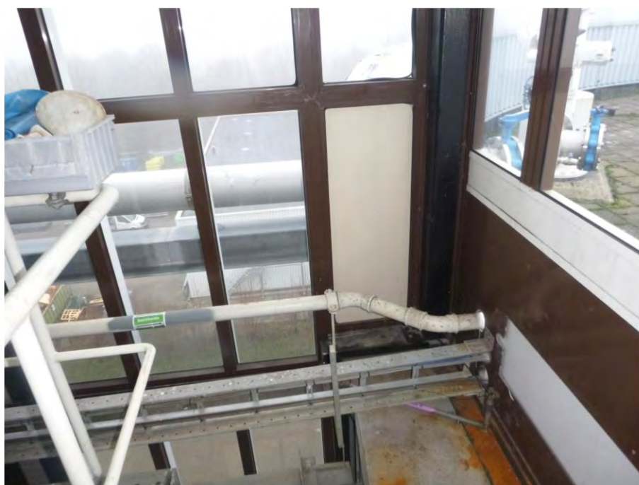
Foto F22, Gevelbeplating type 2 - Slipgistingtank 1 & 2
