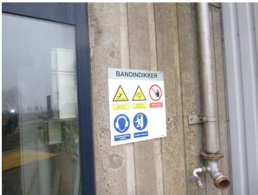
Foto F27, Gevelbeplating type 2 - Dienstgebouw 2
