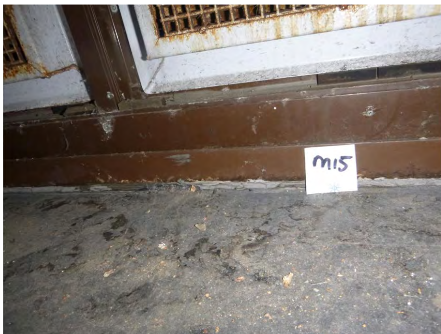
Foto F78, Afdichtingskit type 3 - Slipgistingstank 1 & 2
