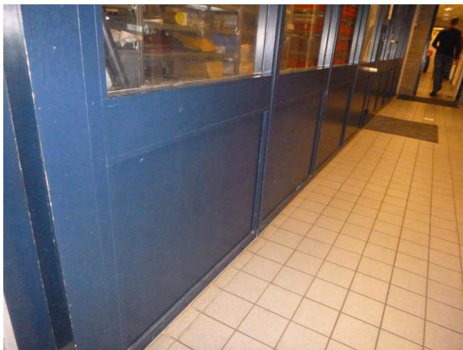
Foto F37, Kozijnbeplating (binnen) - Dienstgebouw 01
