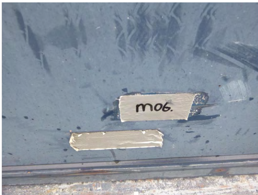
Foto F13, Gevelbeplating type 2 - Dienstgebouw 01
