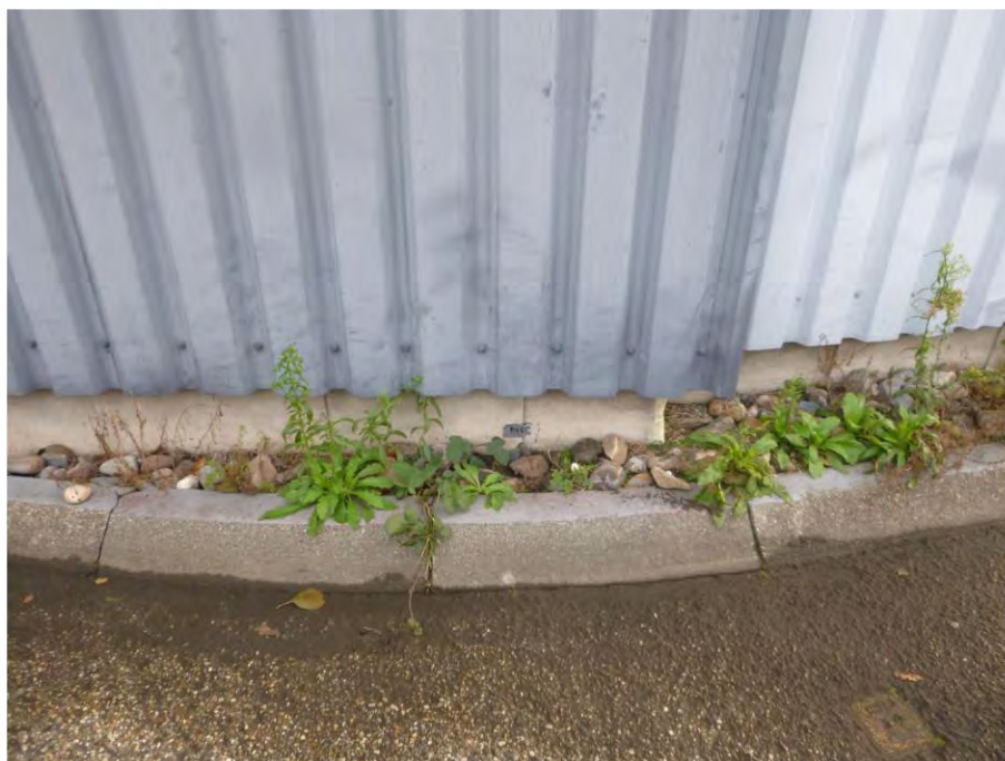
Foto F63, Beplating - Slippistingstank 1 & 2
