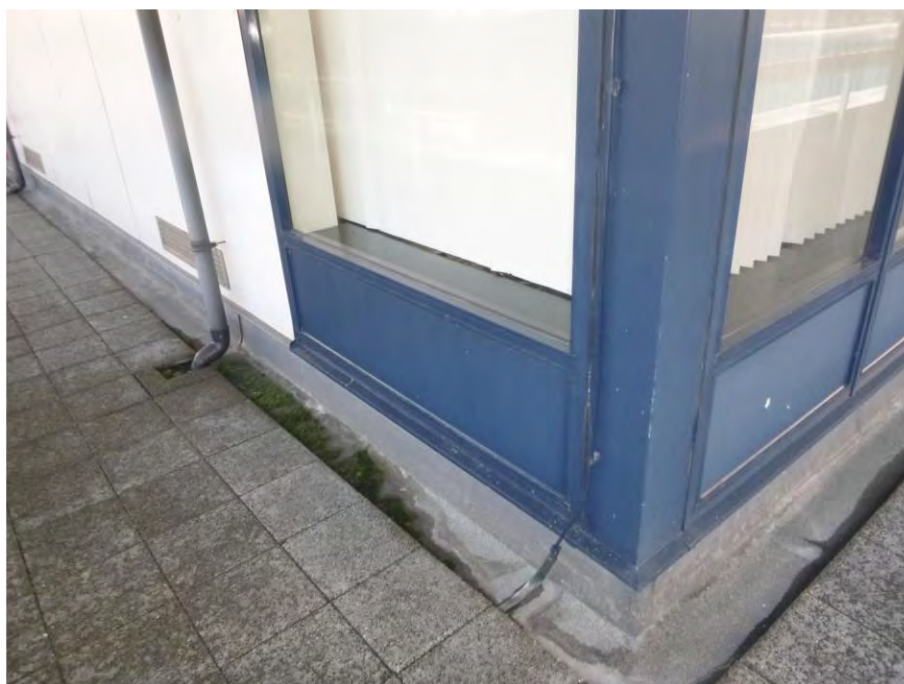
Foto F20, Gevelbeplating type 2 - Dienstgebouw 01
