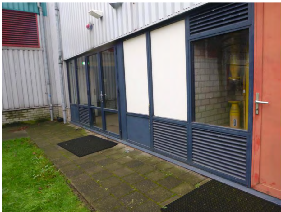
Foto F17, Gevelbeplating type 2 - Dienstgebouw 01
