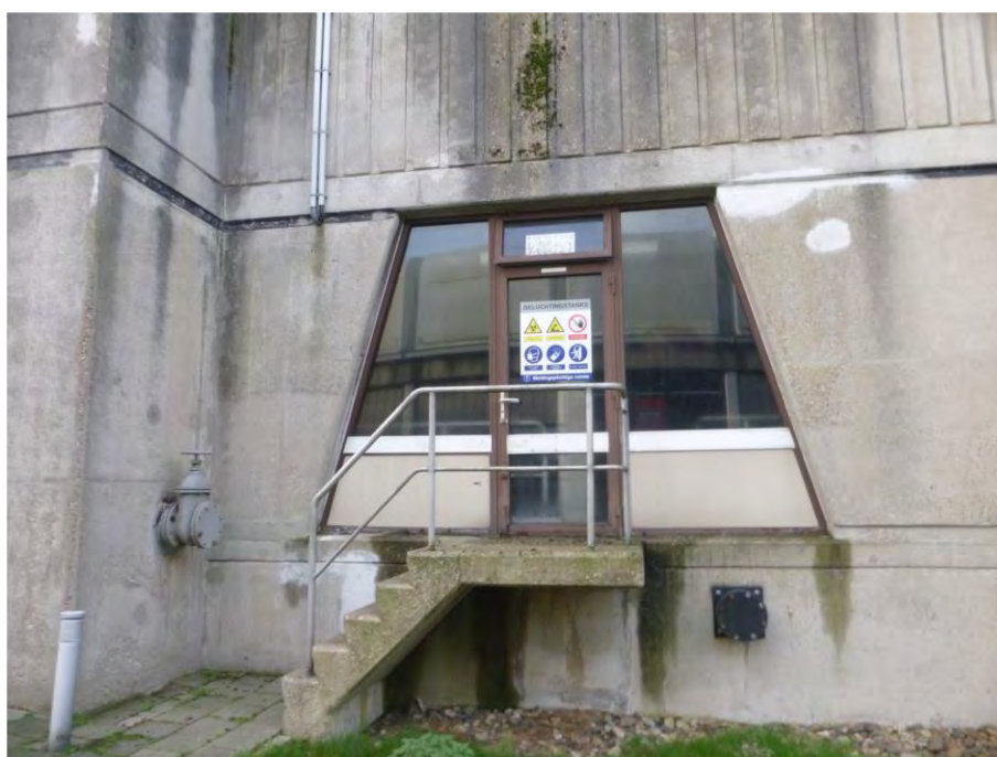
Foto F30, Gevelbeplating type 2 - voorbezinktanks / beluchtingstanks
