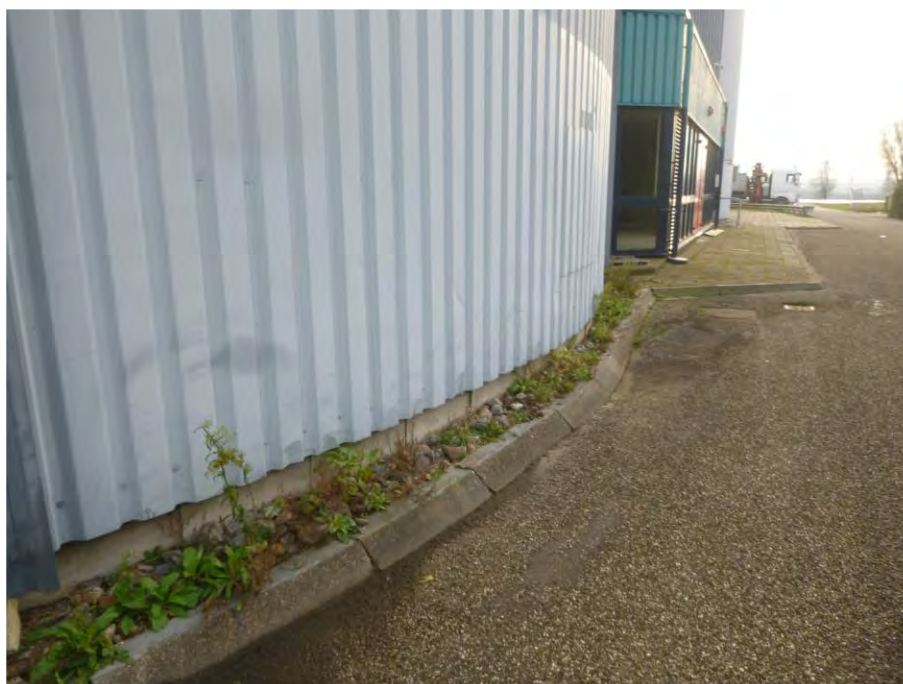
Foto F64, Beplating - Slippistingstank 1 & 2
