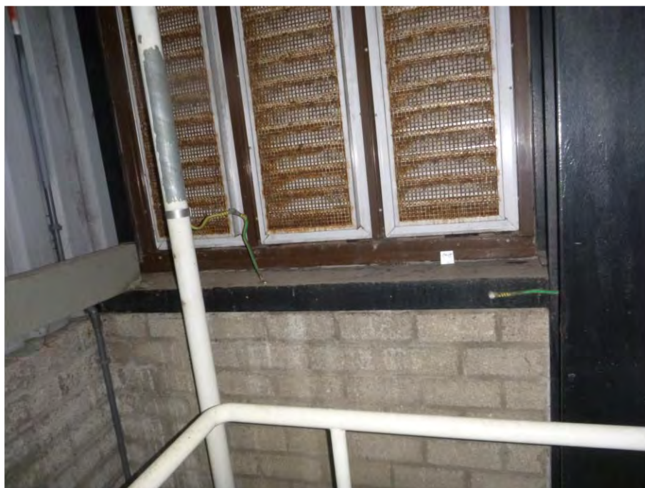
Foto F79, Afdichtingskit type 3 - Slipgistingstank 1 & 2
