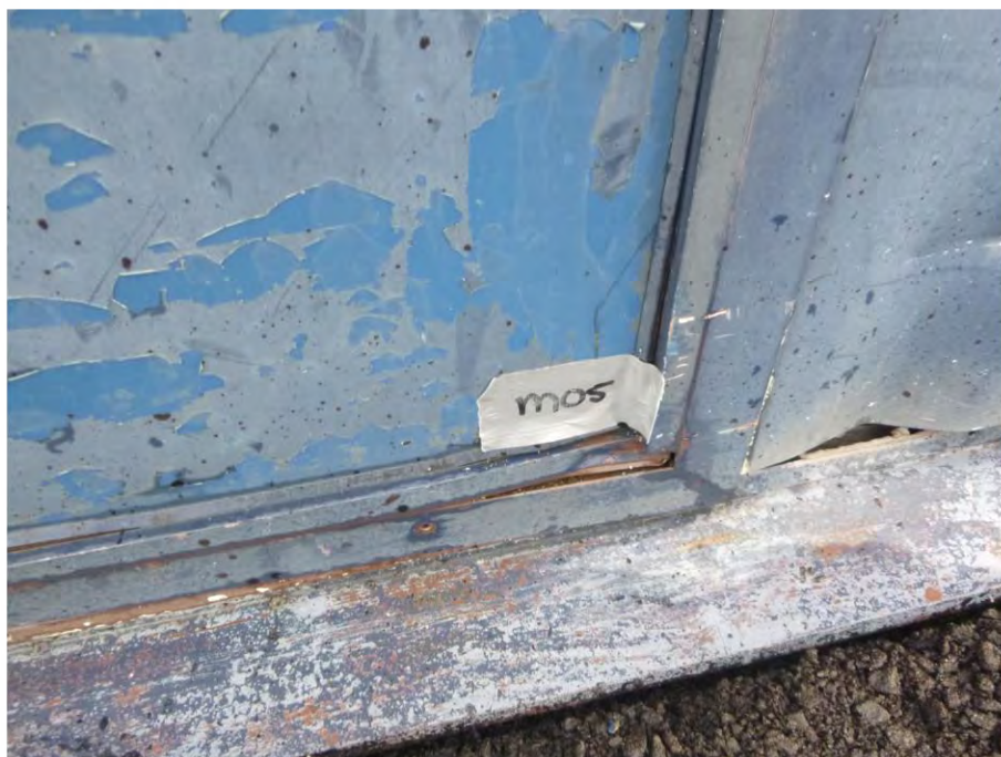
Foto F11, Gevelbeplating type 1 - Dienstgebouw 01
