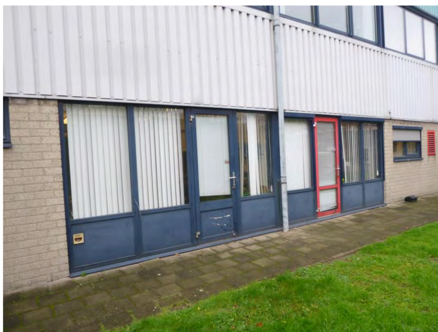
Foto F16, Gevelbeplating type 2 - Dienstgebouw 01
