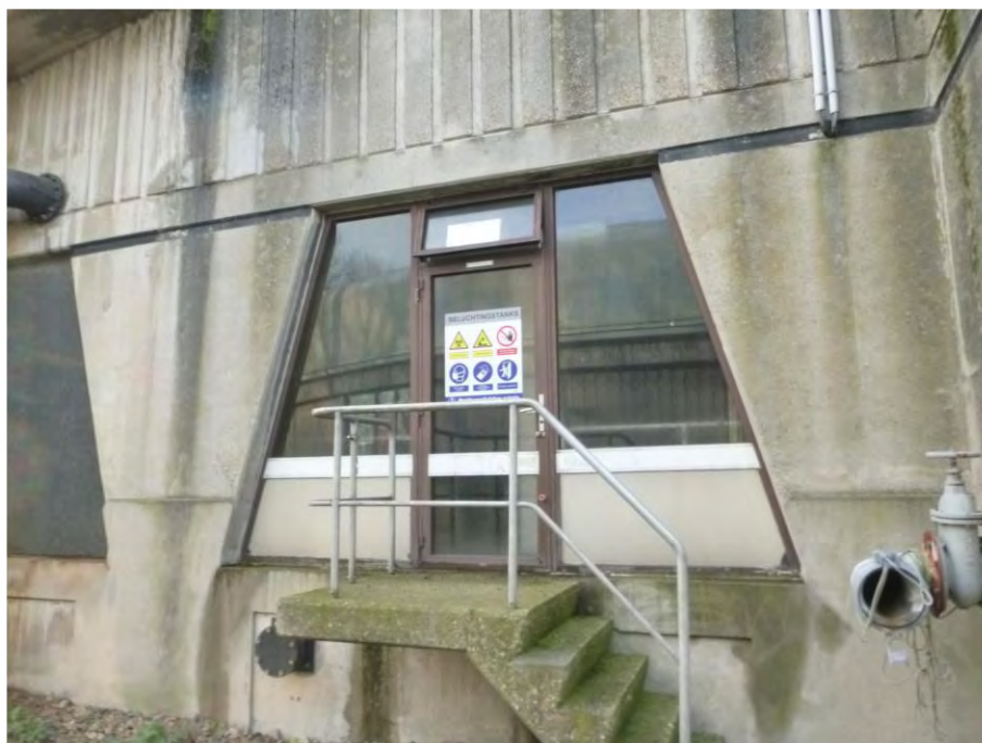
Foto F35, Gevelbeplating type 2 - voorbezinktanks / beluchtingstanks
