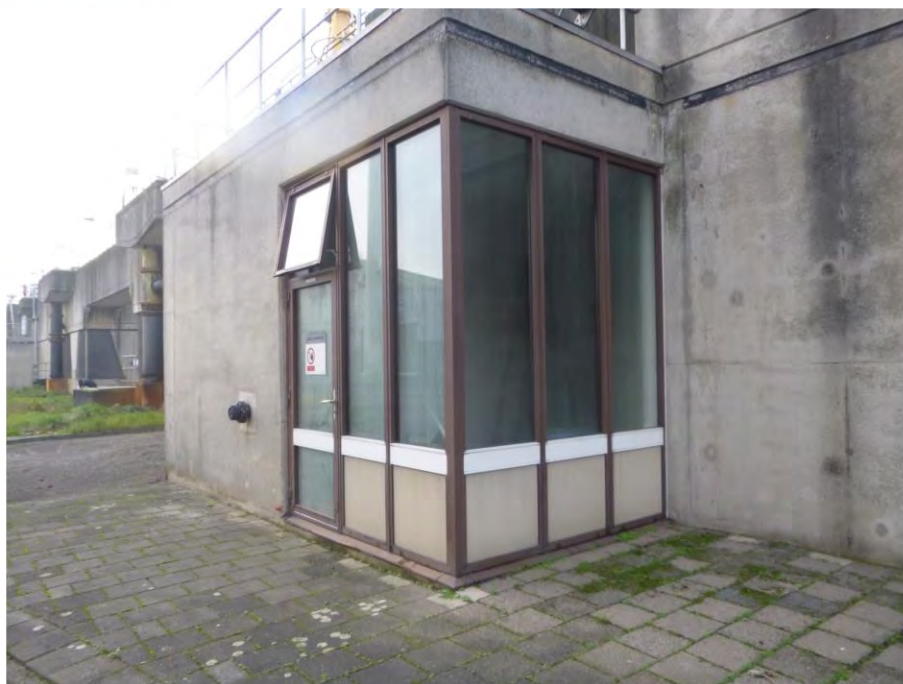
Foto F31, Gevelbeplating type 2 - voorbezinktanks / beluchtingstanks
