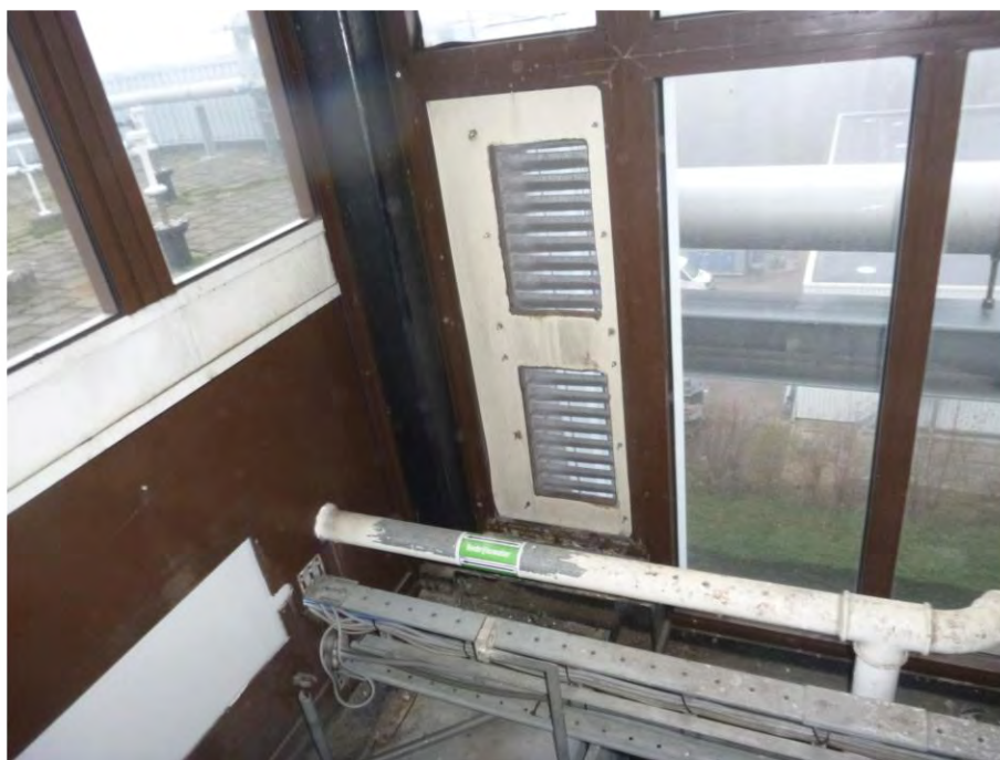
Foto F24, Gevelbeplating type 2 - Sliggistingstank 1 & 2
