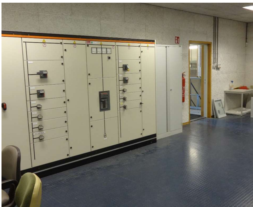
Figuur 3 Bestaande hoofdverdeler HVK-ALG-01
