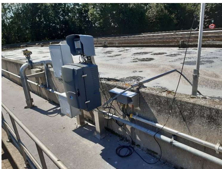
Figuur 18 De nieuwe analysers op BT1 met rechts ervan de nieuwe lasdoos en WCD's onder de RVS kap
