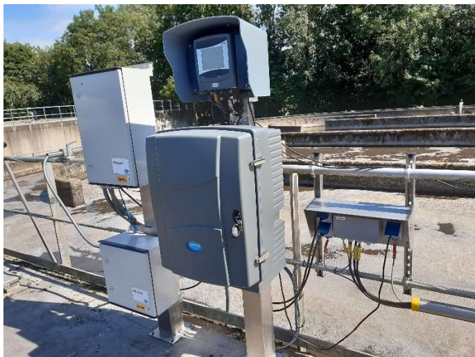
Figuur 19 De nieuwe analysers op BT2 met rechts ervan de nieuwe lasdoos en WCD's onder de RVS kap
