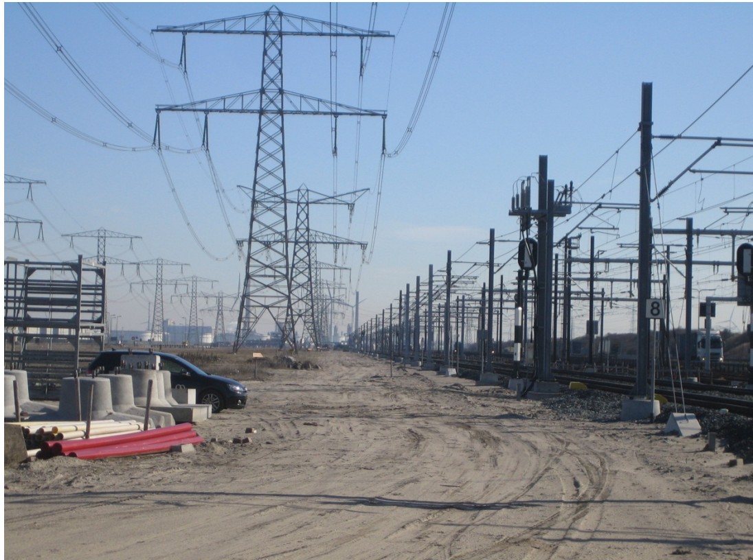
Figuur 1: Parallelloop bovenleiding en TENNET hoogspanningslijn
