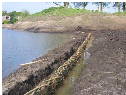
soort beschoeiing: paalwiepenbeschoeiing functie: tijdelijk behoud doorstroomprofiel
