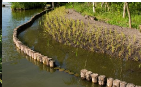
Soort beschoeiing: palenrijbeschoeiing functie: behoud doorstroomprofiel
