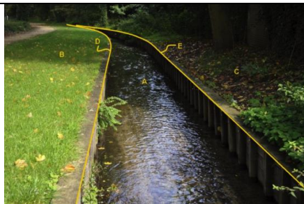
soort beschoeiing: paalschot materiaal: hardhout functie: behoud doorstroomprofiel
