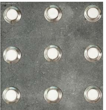
waarschuwingsmarkering bij oversteek; stalen noppen op natuursteen
