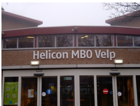
Gevelbelettering onverlicht, kunststof losse letters, maatvoering onbekend
