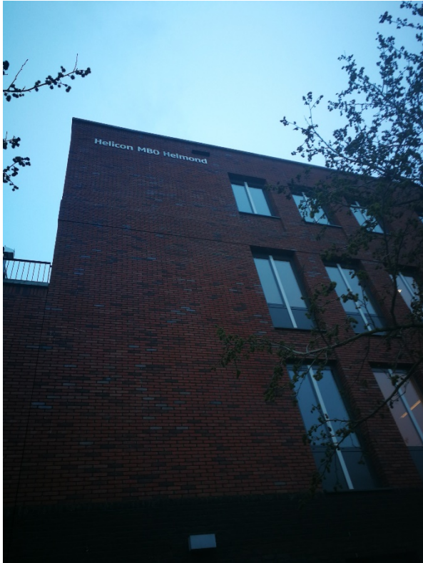
Gevelbelettering (kunststof onverlicht) aan de noordkant van het gebouw (3 e verdieping), maatvoering onbekend
