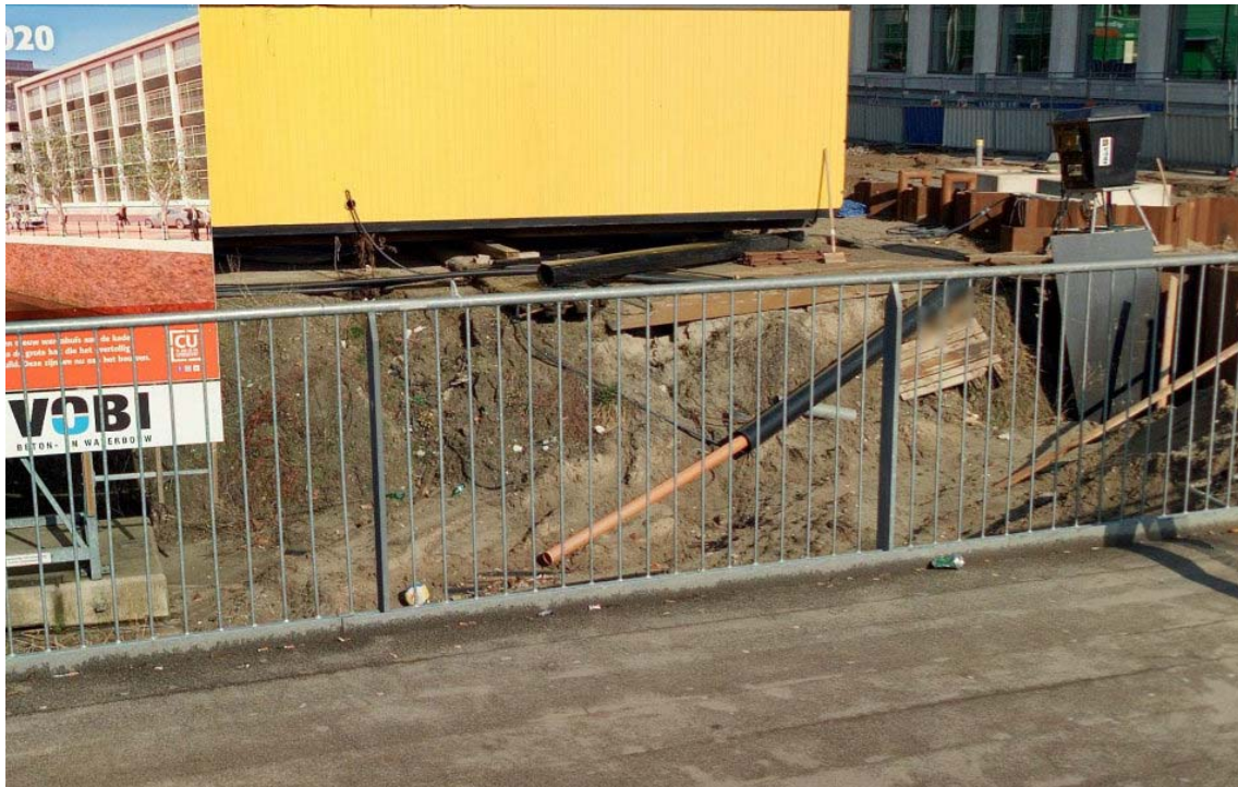
Foto 4: bestaand te verwijderen hekwerk Marga Klompébrug
