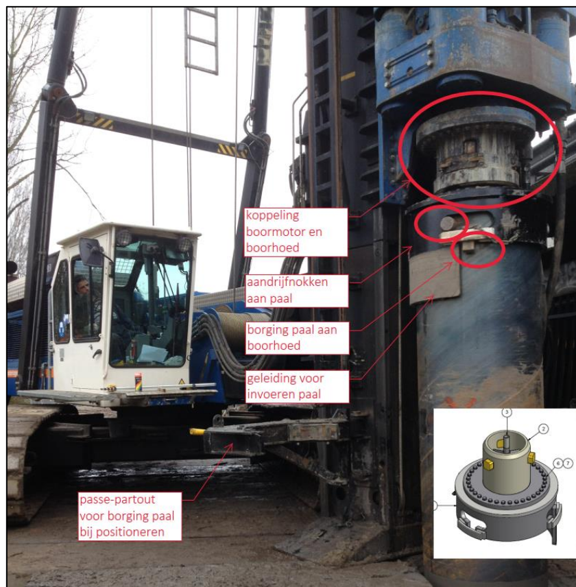
Figuur 37 – Borging bovenzijde TVSI-paal
