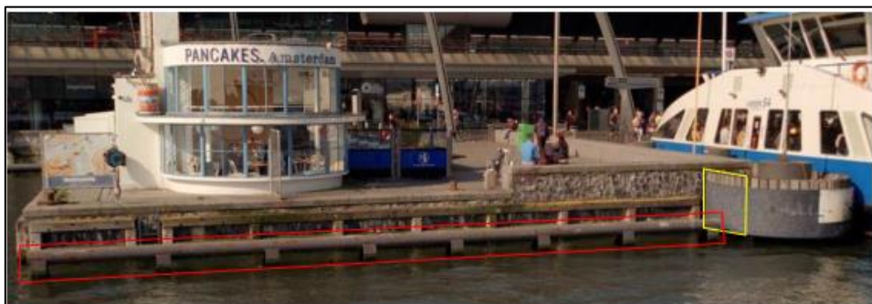
Figuur 105 Aanvaarbescherming en remmingwerk Pier 10
