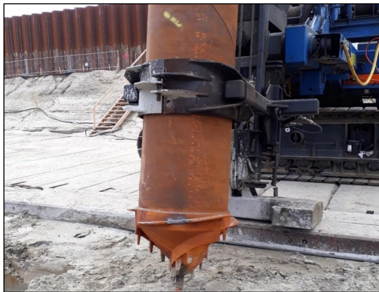
Figuur 35 – Insluiting onderzijde middels passe-partout
