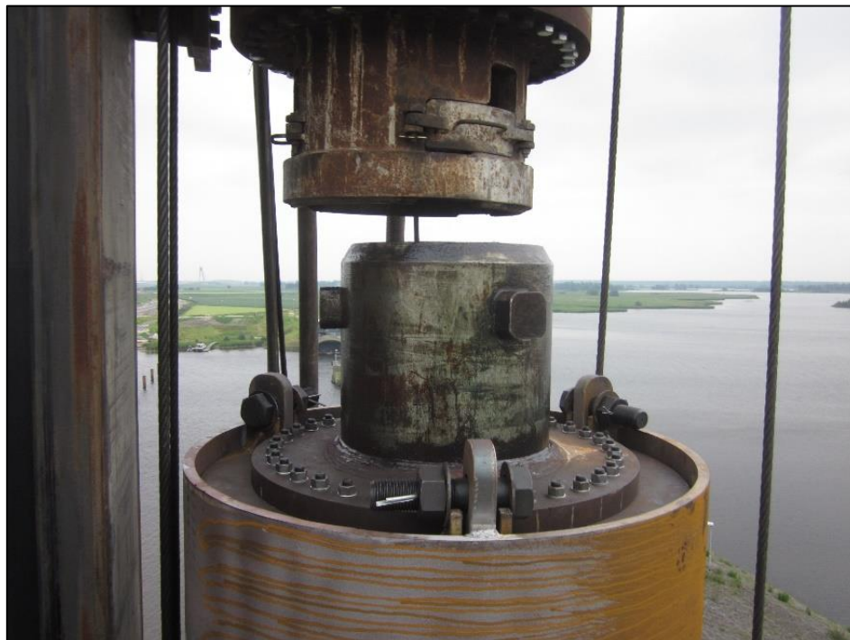
Figuur 38 – Borging bovenzijde geschroefde open stalen buispaal (de boorkoppeling en boorhoed zijn al gekoppeld voordat de paal wordt opgepakt, de koppeling paal/boorhoed gaat middels bouten met moeren en splitpennen)
