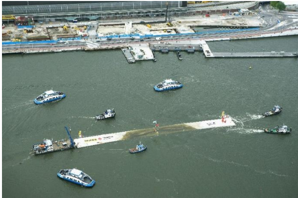
Voorbeeld route pontjes tijdens transport element voor de NZ-lijn
