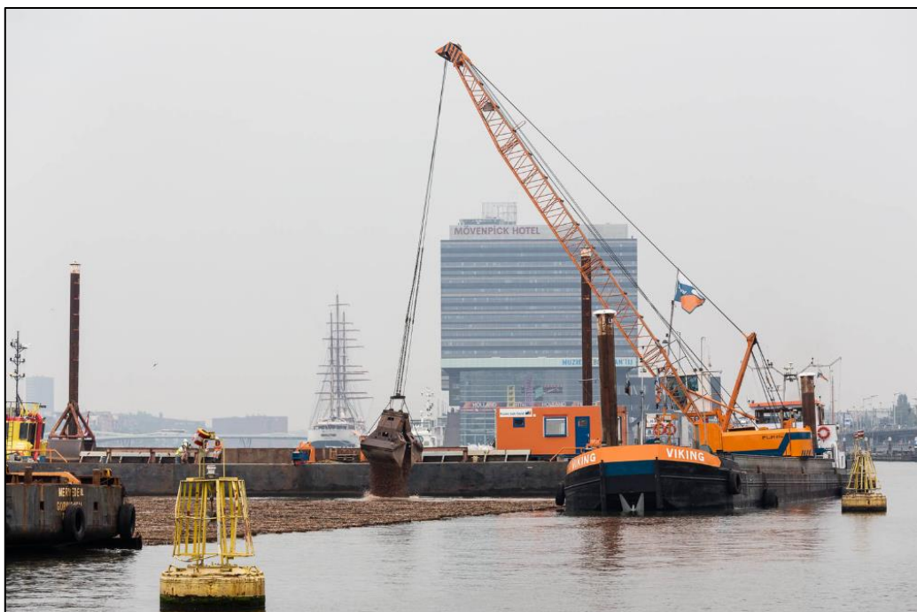
Figuur 32 - Aanbrengen zinkstukken tijdens realisatie Noord/Zuidlijn
