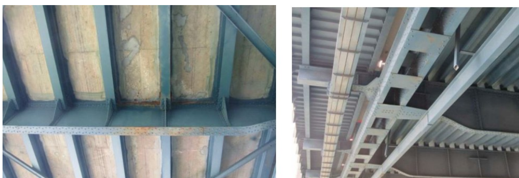
Figuur 3: Onderaanzichten betonnen rijdek vaste bruggen en stalen rijdek hefbruggen
