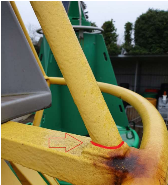
Afbeelding7: doorslijpen spinnenkop
