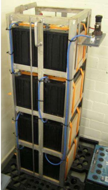
Afbeelding 16: accurek met spanbanden
