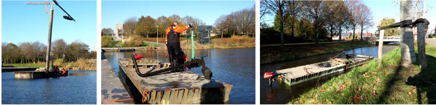
Figuur 23: Het hijsen van de pomp door middel van twee koppelbare werkpontons met een handmatige takel.
