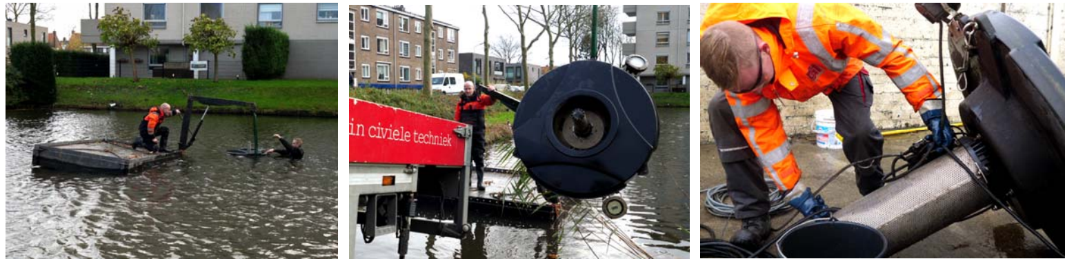
Figuur 26: Het uithijzen, opladen en reinigen van de pomp.
