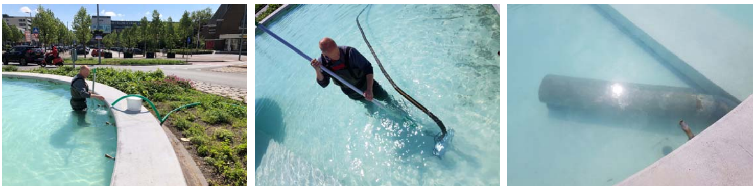
Figuur 28: De werkzaamheden bij het reinigen van de fontein Beursplein.
