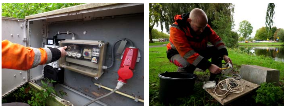
Figuur 16: Het handmatig uitzetten van de hoofdschakelaar en het demonteren van de draden van de pompkabel.
