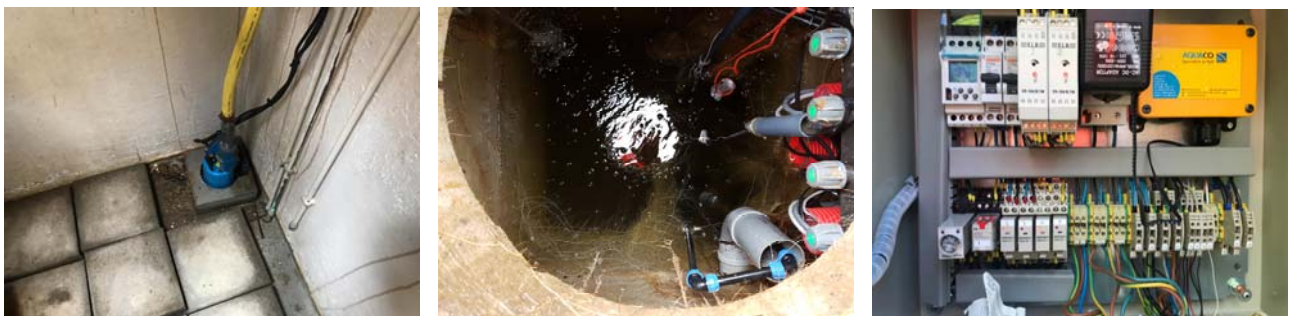
Figuur 31: Het bijhouden van de pompkelder, mogelijke wortel ingroei en de elektriciteitskast.
