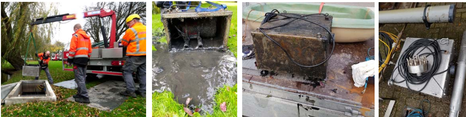
Figuur 4: Het hijsen, ontzien van modder en water en het reinigen van de pomp unit.
