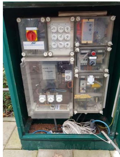
Figuur 6: De elektriciteitskast en het loshalen van de rode 400V stekker.
