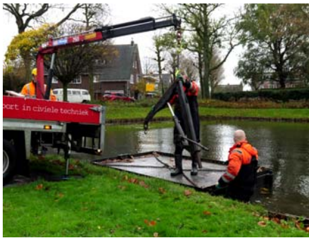
Figuur 7: Het in- uithijsen van het werkponton met handmatige takel en het hijsen van de pomp in het water.
