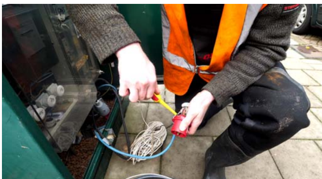
Figuur 6: De elektriciteitskast en het loshalen van de rode 400V stekker.
