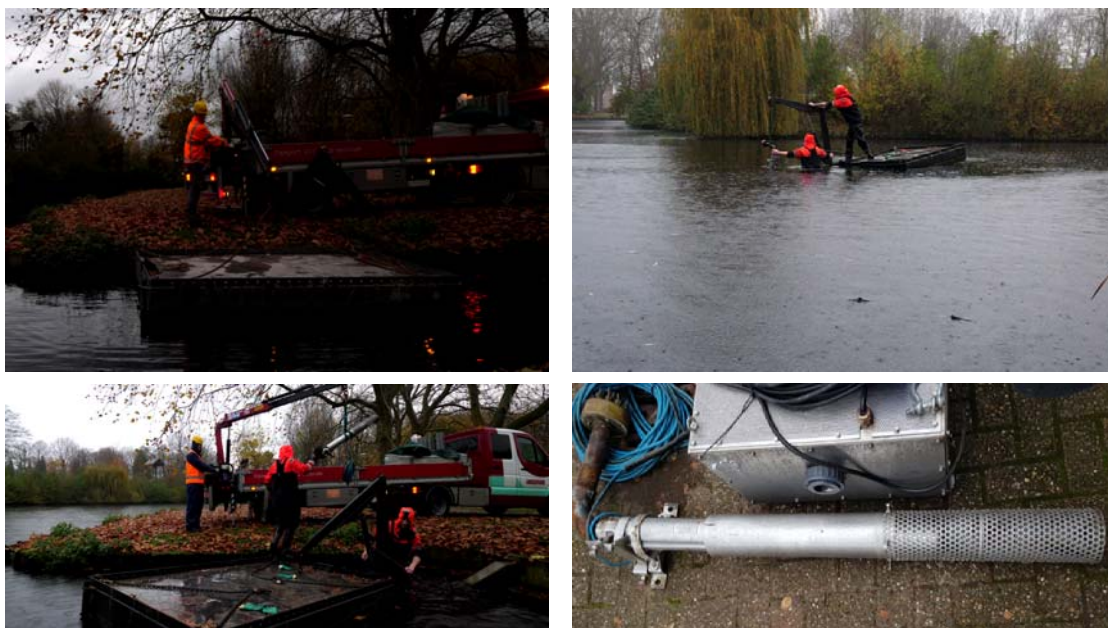
Figuur 14: Het vervoeren, hijsen en het reinigen van de pomp.
