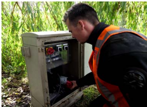
Figuur 25: Het uitschakelen van de hoofdschakelaar en het trekken van de kabel.
