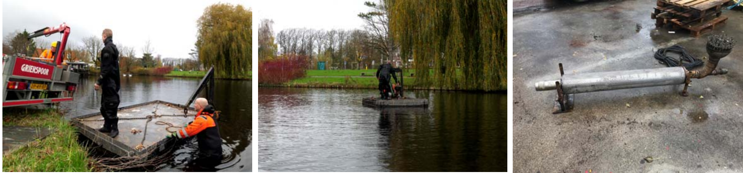
Figuur 17: Het vervoeren, hijsen en reinigen van de pomp.
