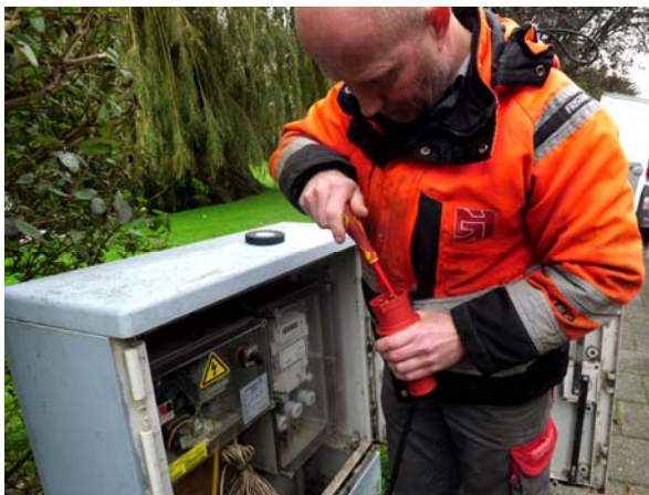
Figuur 2: De elektriciteitskast en het demonteren van de rode 400V stekker.
