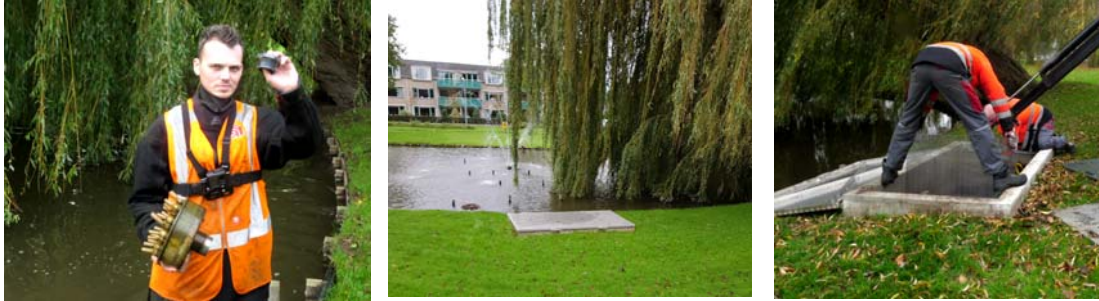
Figuur 3: Het verwijderen van de spuitkop, de locatie van het afsluitluik en een filterscherm wat verwijderd wordt.
