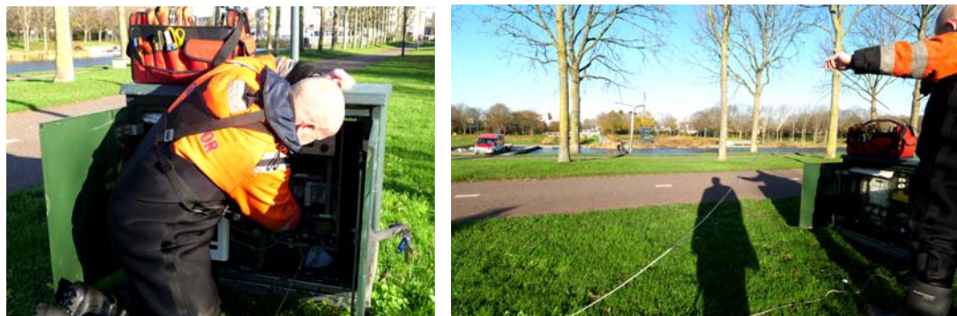
Figuur 22: Het demonteren en trekken van de kabels afkomstig van de pomp
