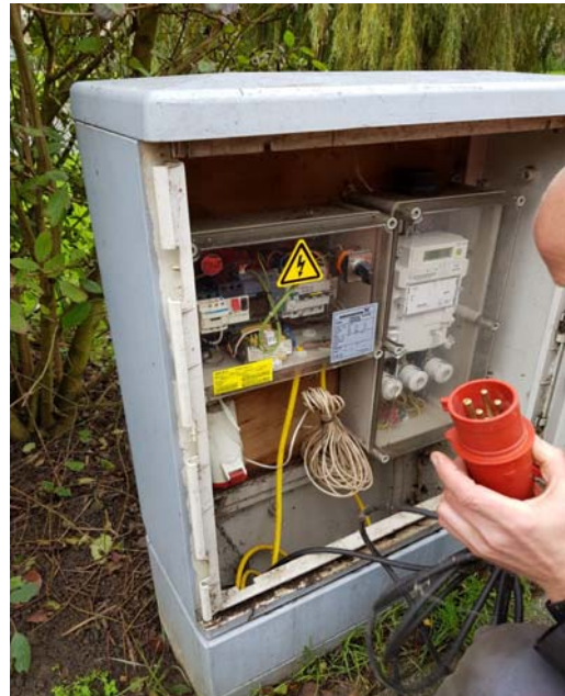
Figuur 2: De elektriciteitskast en het demonteren van de rode 400V stekker.
