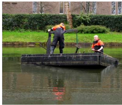
Figuur 7: Het in- uithijsen van het werkponton met handmatige takel en het hijsen van de pomp in het water.
