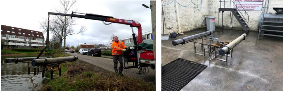
Figuur 11: Het hijsen van de pomp uit het water met behulp van een autolaadkraan en het reinigen van de pomp.
