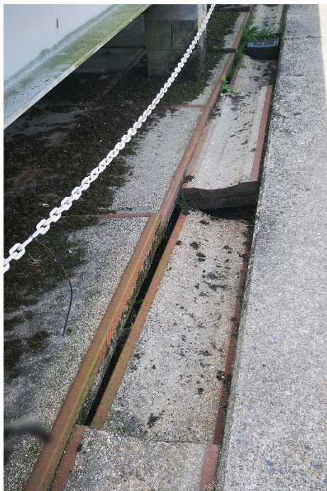
Figuur 4-4 -detail verzakte goot
