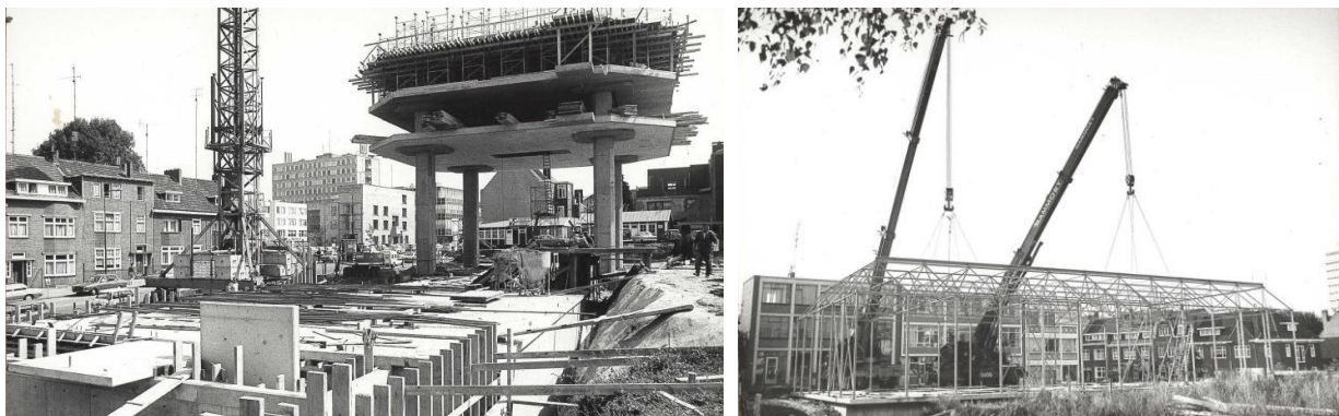
Figuur 2-2 Bouw Thermenmuseum in Heerlen (TheHe)
