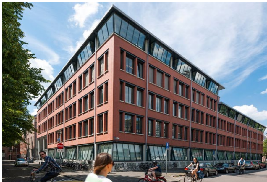
Buitenzijde Gerechtsgebouw Groningen
