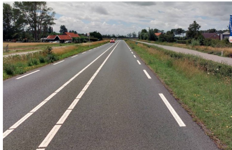
Hm 71,5 fietspad rechts tussen HRB en parallelweg
