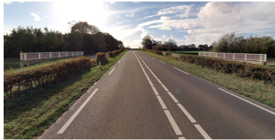
Hm 53,6 onderdoorgang Moerweg (illegale oversteek hoofdrijbaan)
