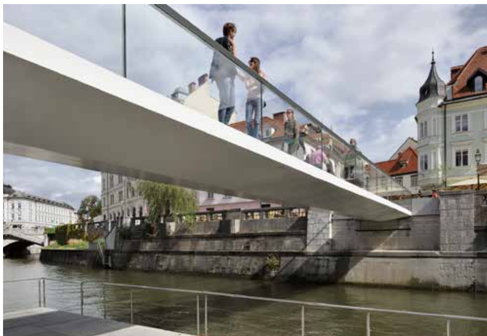
Fietsverbinding Eikenlaan-Walfridusbrug: BKP Fietsbrug
