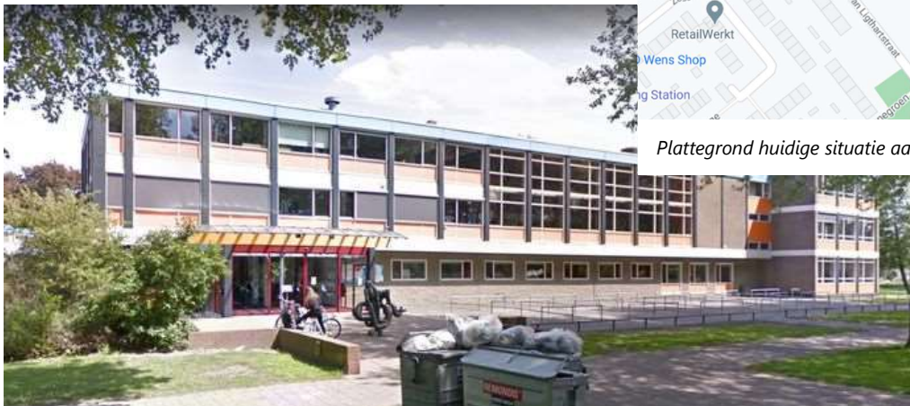
Foto van frontgevel Jan Ligthartstraat 1
