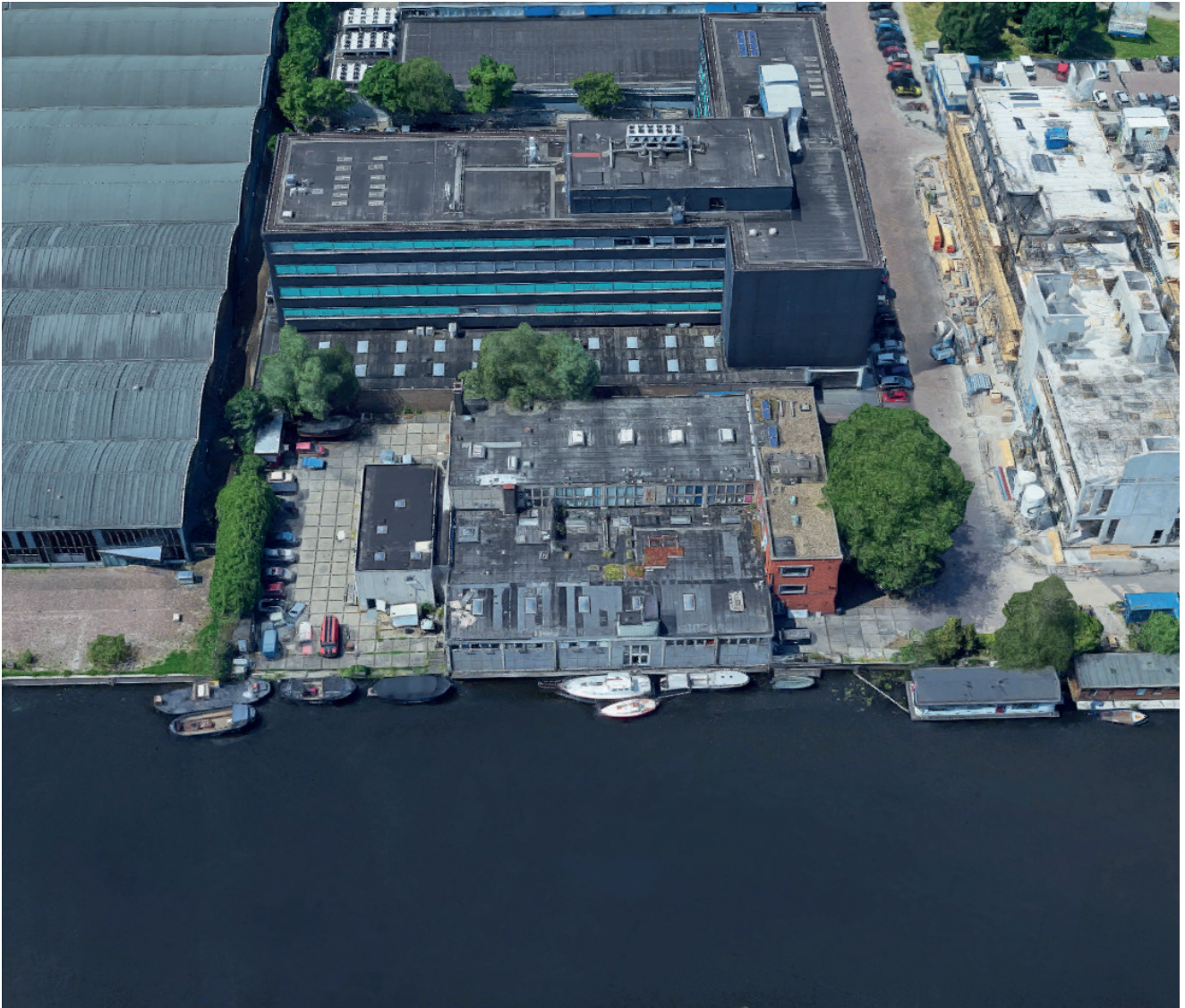
Luchtfoto van de voormalige 'Koffiefabriek' met daarachter het bedrijfsverzamelgebouw Johnny River
