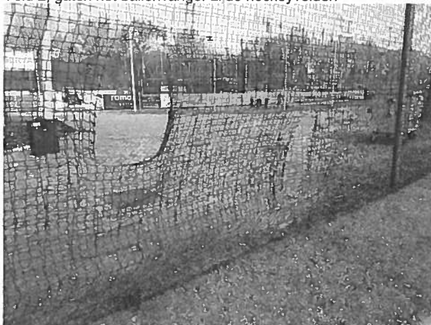
Veld 2: gaten net ballenvanger zijde hockeyvelden
