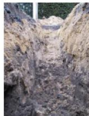
Foto: zijaanzicht proefsleuf
