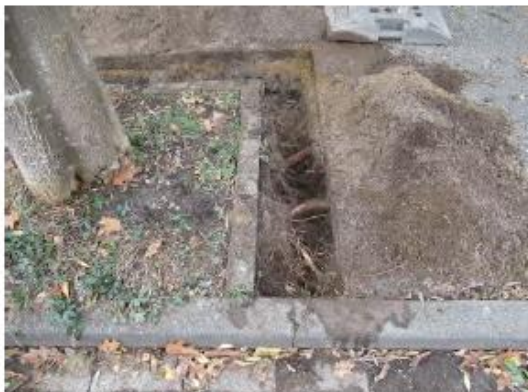
Foto: proefsleuf zijkant haaks op de weg
