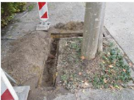
Foto: proefsleuf achterzijde evenwijdig aan weg
