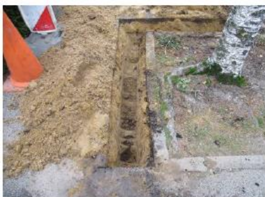
Foto: proefsleuf achterzijde evenwijdig aan weg
