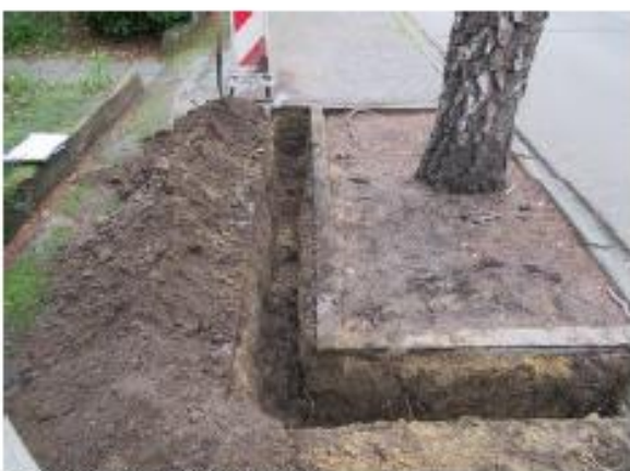
Foto: proefsleuf achterzijde evenwijdig aan weg
