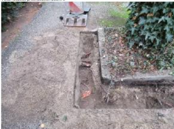
Foto: proefsleuf achterzijde evenwijdig aan weg
