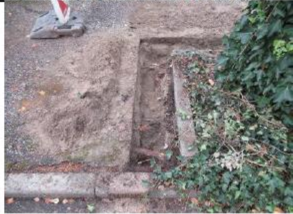
Foto: proefsleuf zijkant haaks op de weg
