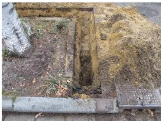
Foto: proefsleuf zijkant haaks op de weg
