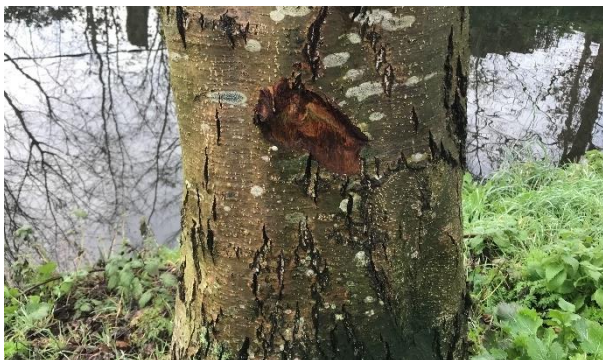
Afbeelding 3: lichte bastschade bij boom 5
