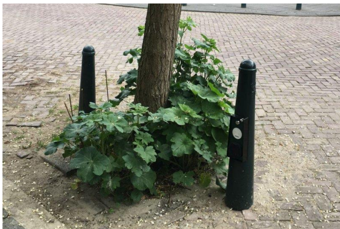
Figuur 5: Voorbeeld geïntegreerde laadoplossing in Hagenaartje uit Den Haag
