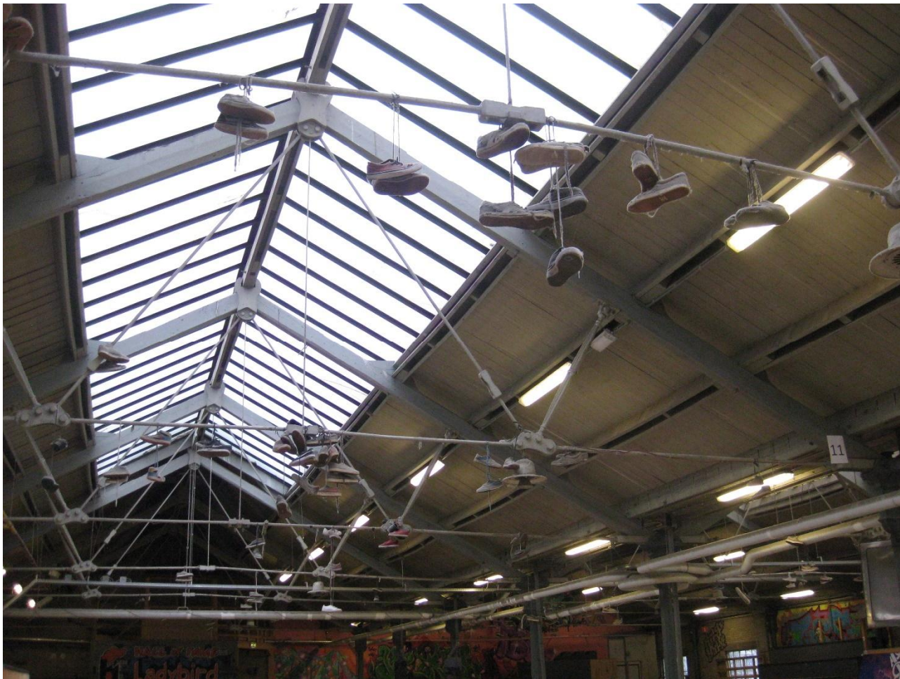
Bestaand dakdeel met een lichtstraat in de lijn van het dakvlak.
