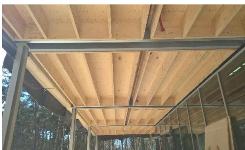
Houten vloerbalklaag in staalconstructie.
