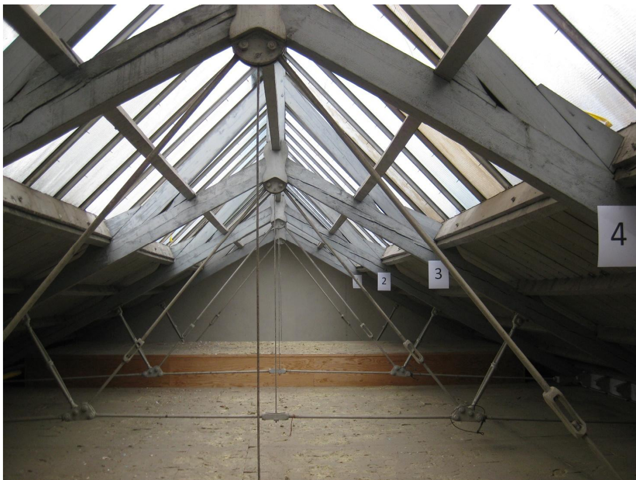
Bestaand dakdeel boven de grote zaal met een verhoogte lichtstraat welke op "houten opzetspanen" op de hoofdspanen van het dak staat.
