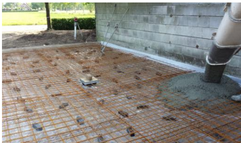
Ter plaatse gestorte betonvloer op bekisting.
