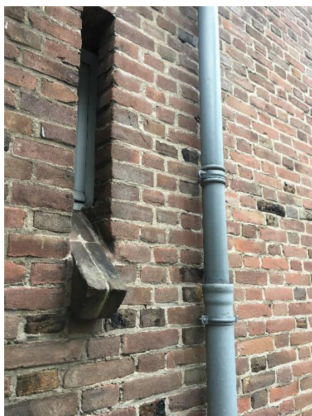
Steens baksteen gevel
