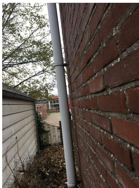
Baksteen gevel met spouw
