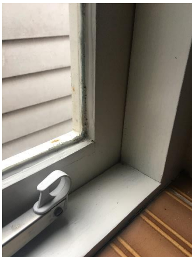
Houten kozijn, enkel glas
