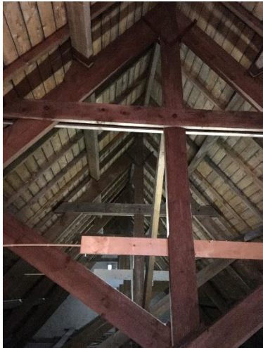
Houten kap, ongeïsoleerd
