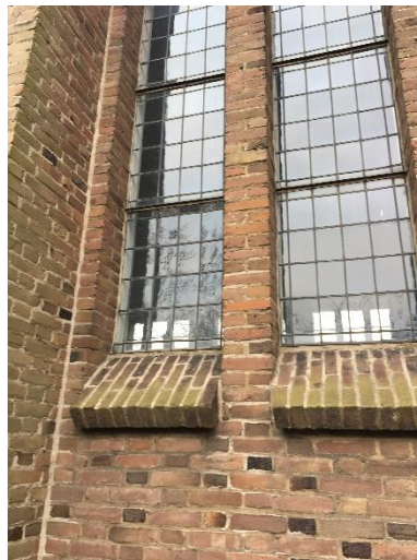
Stalen kozijn, glas-in-lood
