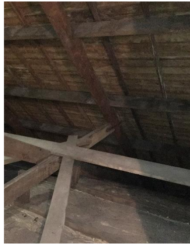
Plafond kerkzaal, glaswol isolatie
