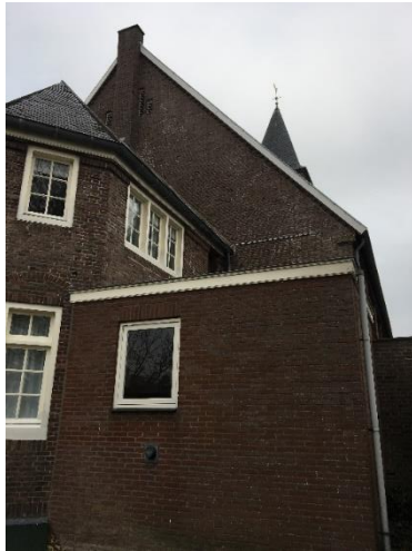
Plat dak, ongeïsoleerd
