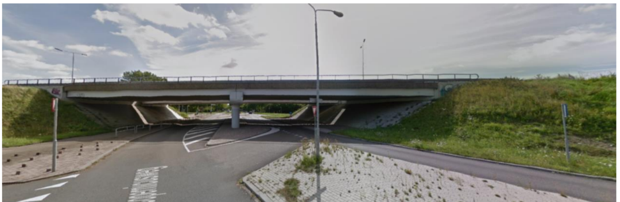
Viaduct Copernicusweg – kruising N3
