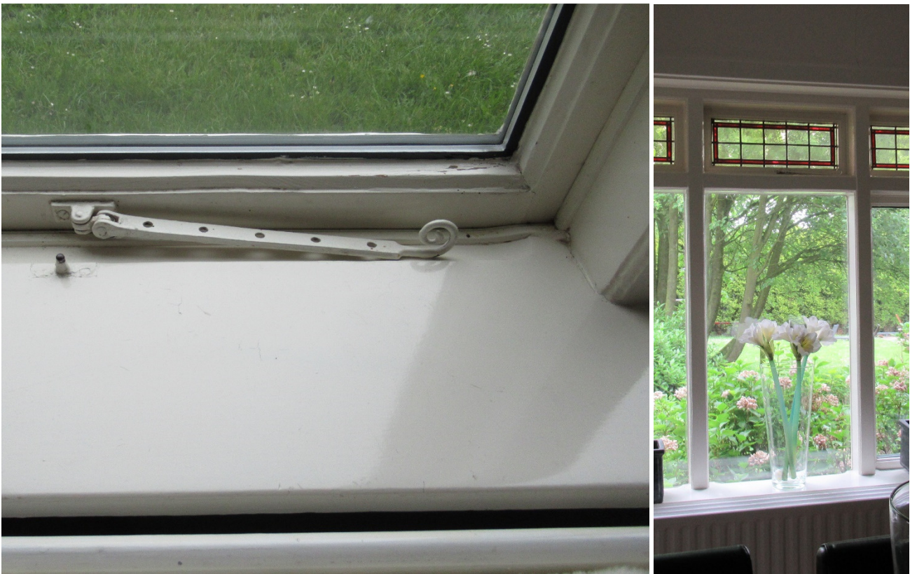
Afb. 1.20-1.21. detail authentieke vensterbank en raam met oorspronkelijke gietijzeren raamuitzetter. Detail glas in lood bovenlichten raampartij eetkamer.
