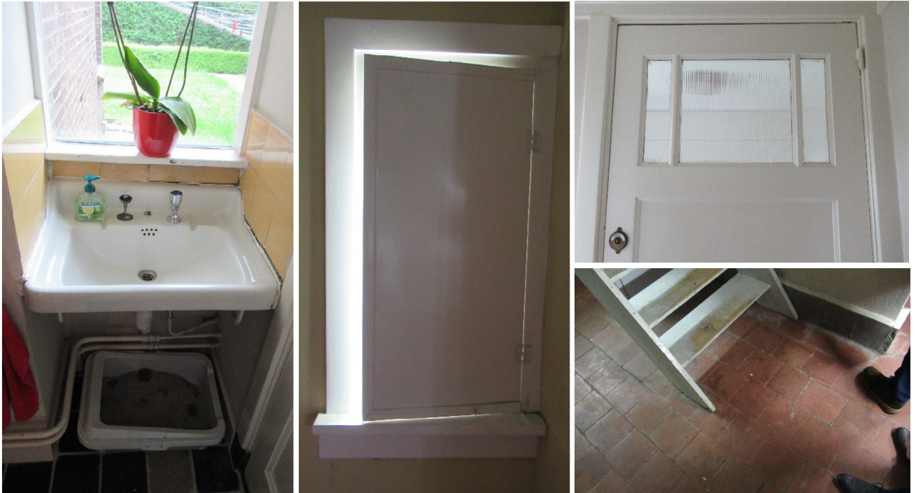
Afb. 1.16-1.19. Spoelbak met oorspronkelijke betegeling, raamluik op zolder, bovenlicht deur van geprofileerd glas en oorspronkelijke keramische keldervloer (2019).
