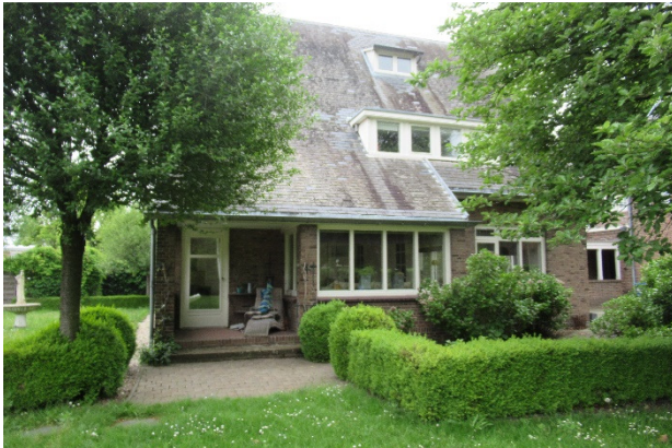
Afb. 1.22 overzicht oostgevel met veranda uitbouw
