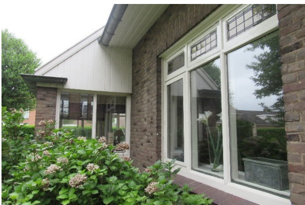
Afb. 1.26. oorspronkelijk raamkozijn oostgevel (eetkamer) Inclusief oorspronkelijk glas in lood bovenramen en draaiende delen.
