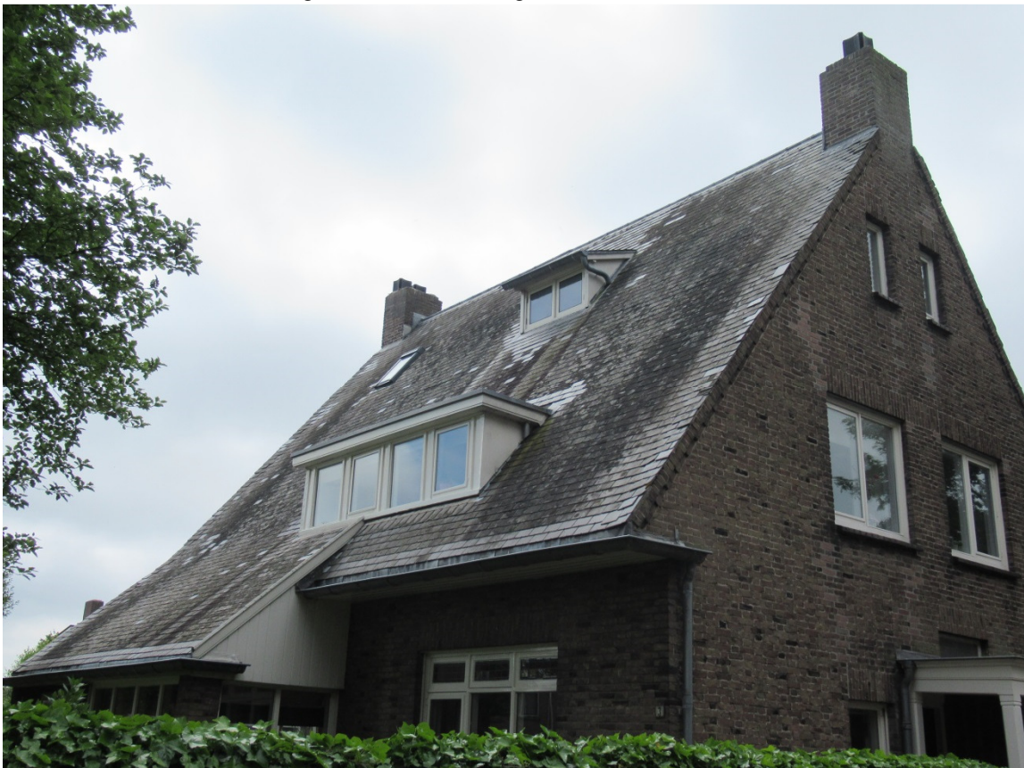
Afb. 6. Het inboetwerk in de leienbedekking tekent zich duidelijk af. (oostzijde woning)
