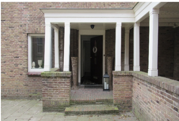
Afb. 1.24. Passage/droogloop bij voordeur naar consistorie
