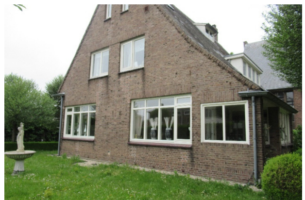
Afb. 1.27. overzicht zuidgevel met grote horizontale raampartijen (kozijnen authentiek, glas modern).
