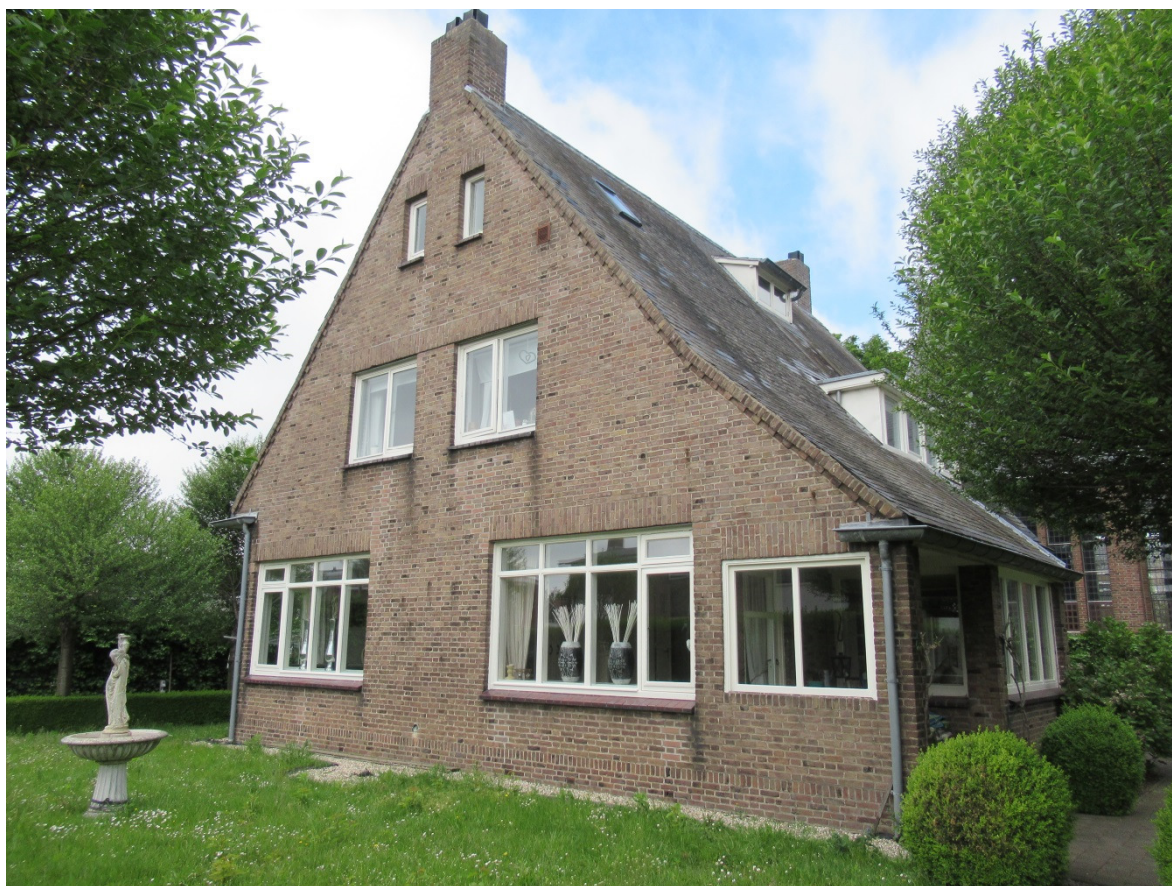
Afb. 1. Voorgevel (2018, noordzijde), bron: Rothuizen AS
