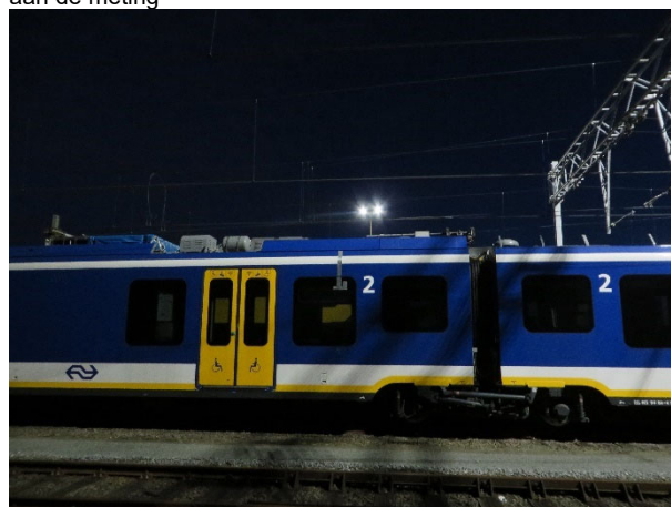
Figuur 4.5: Lichtmast 4 gezien vanaf het terrein van NS werkplaats
