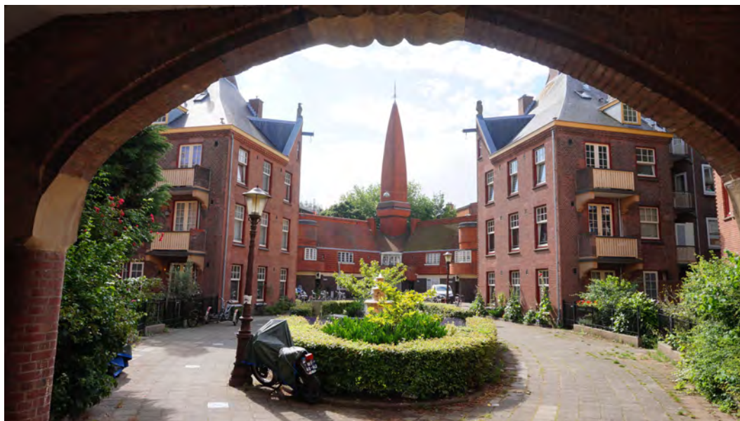
Doorkijk naar 'Het Schip' vanaf het pleintje aan de Hembrugstraat/Entree Zaanhof.
