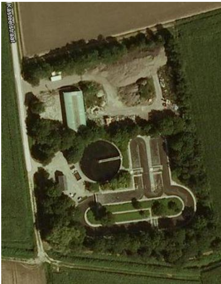
Figuur 2: rwzi Ossendrecht, Kasteelstraat Ossendrecht
