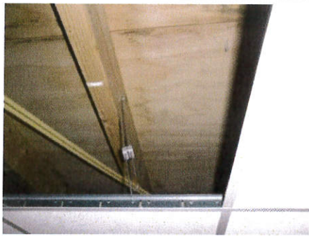
Boven systeemplafond houten dak
