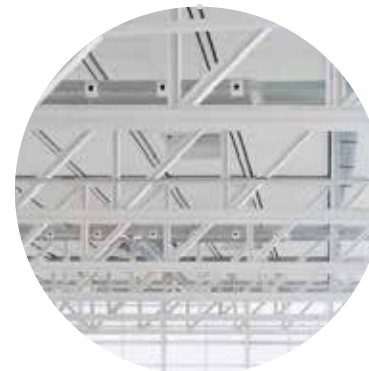
staalconstructie met geperforeerde stalen dakplaat
