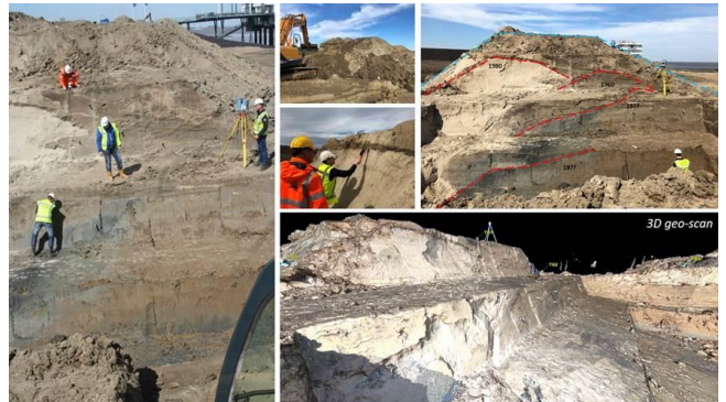
Figuur: Geo-scan afgegraven dijk kern bij toekomstig stadsstrand Marconi, Delfzijl (opname 25 april 2019).
