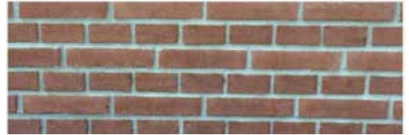
Afwerking kademuren tussen woningen: metselwerkbaksteen roodbruin waalformaat kruisverband type steen: Rodruza WF VB Parse klinker speciaal 101717
