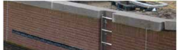
Uitklimtrap RVS verwerkt in de kadeconstructie
