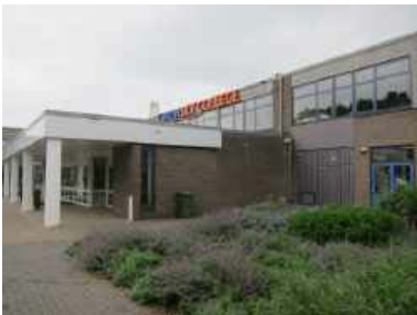
Foto bestaande entree en impressie nieuwe entrees (hoofdgebouw en sportgebouw)
