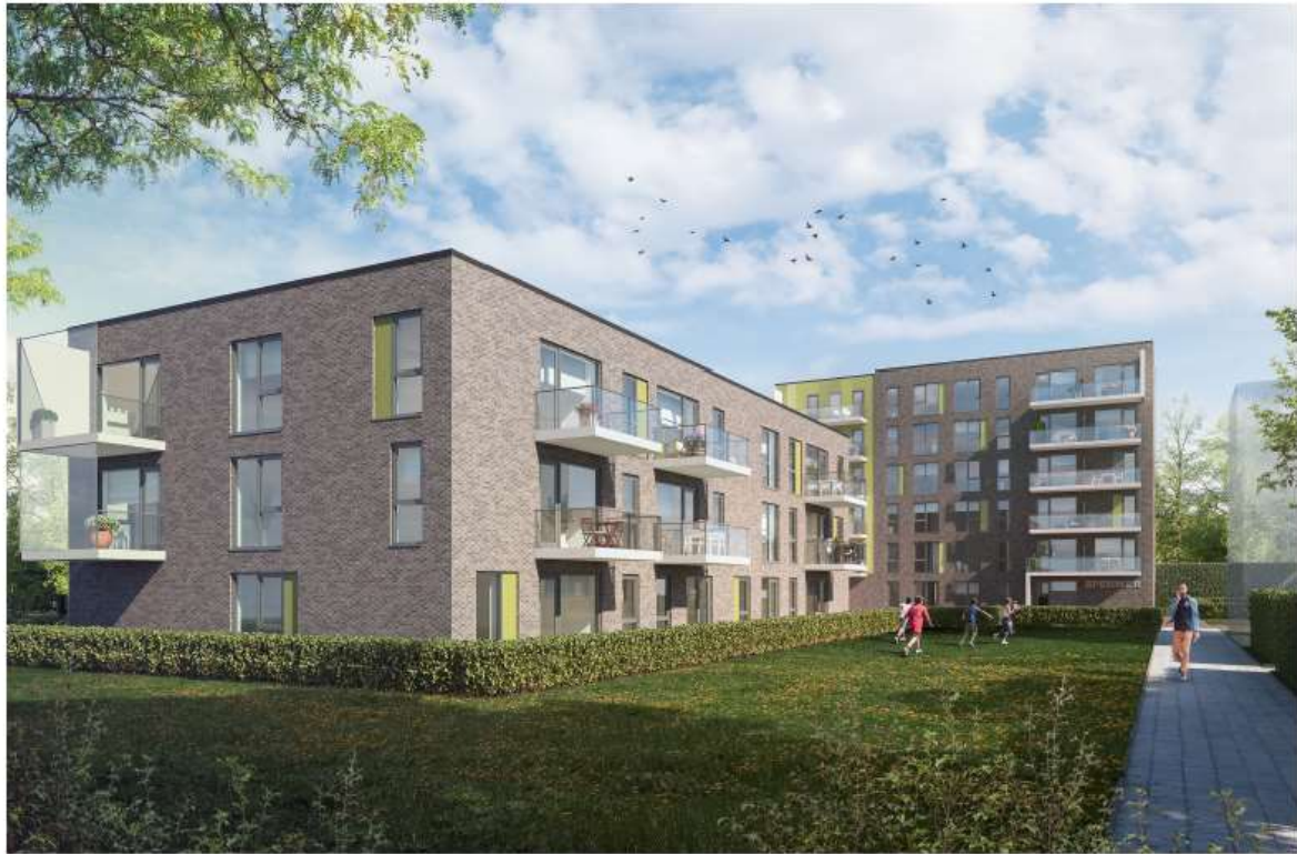
Gebouw 1 en 2 krijgen op de koppen geluidschermen langs de balkons. Door een witte schijf worden deze schermen bedrukt. Verticale schijven vormen ook samen met tuifel en balkons de accentuering van de hoofdentrees van de woongebouwen.
