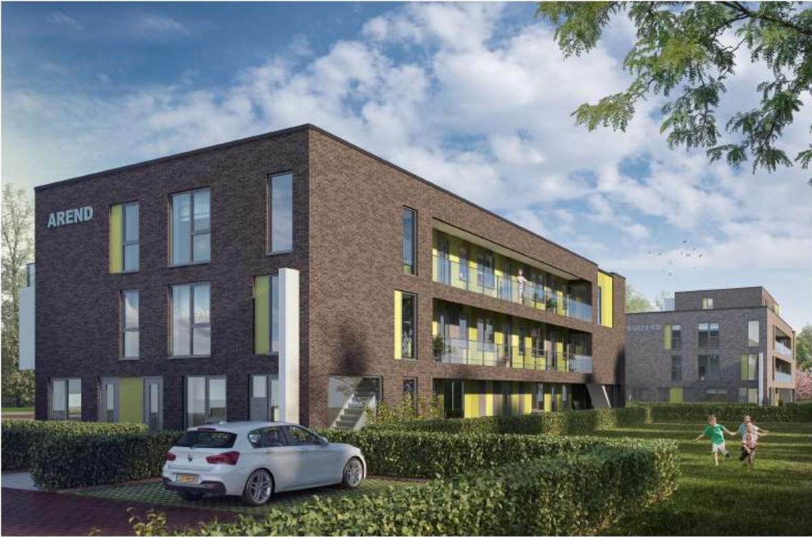
Gebouw 4, galerijuitzicht is opgenomen in de massa van het gebouw en zichtbaar aanwezig langs Schietweg. Groene glaspanelen bij binnenkomst galerij zorgen voor een prettiere uitstraling. Hoofdentree is zijgevel in het zicht en geaccentueerd door een verticale element.
