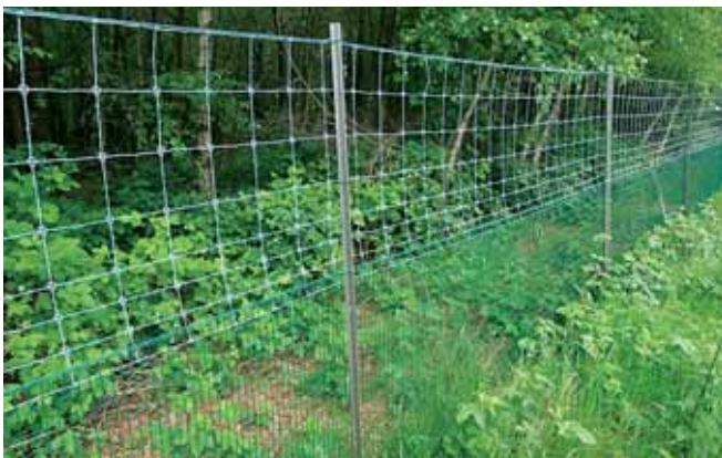
Combinatie van rasters voor grote (boven) en kleinere zoogdieren (onder).
