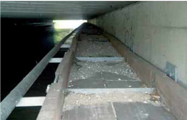
Onder: zandlaag op loopplank verdwenen.
