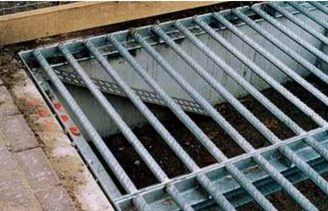
Boven: roosterput schoon en voorzien van uitklimvoorziening.
