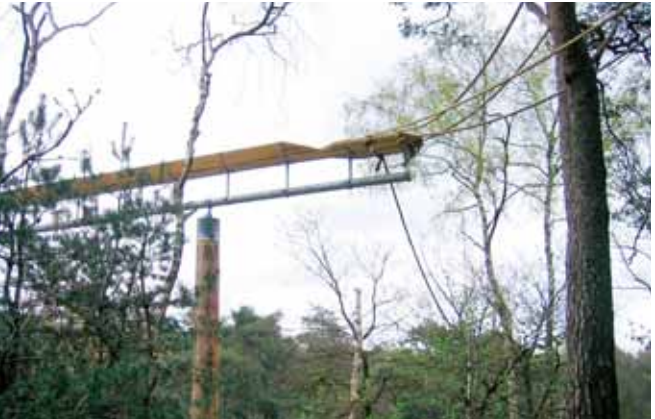
Boven: goede verbinding tussen loopgoot en bomen.
