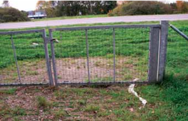
Boven: werkpoort gesloten, raster loopt door op de poort.
