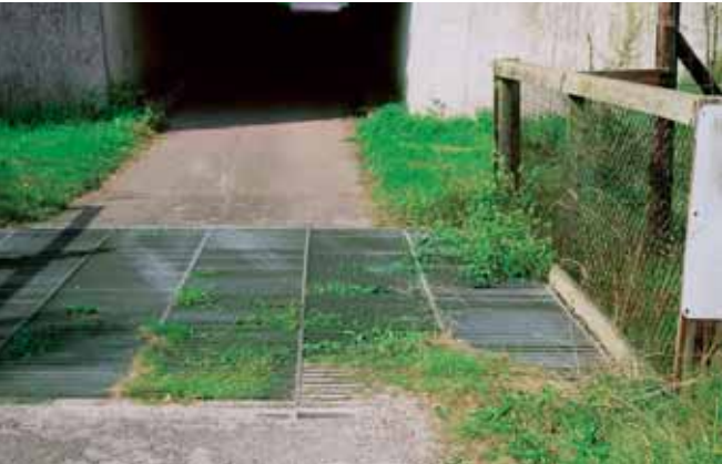
Onder: rooster is dichtgeslibd met zand.
