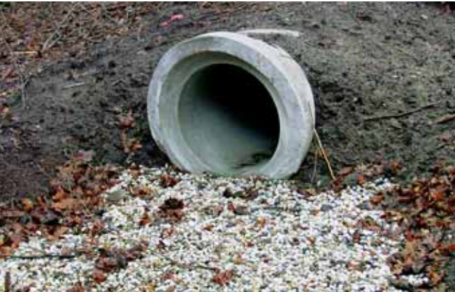
Boven: grindkoffer laat water goed door.
